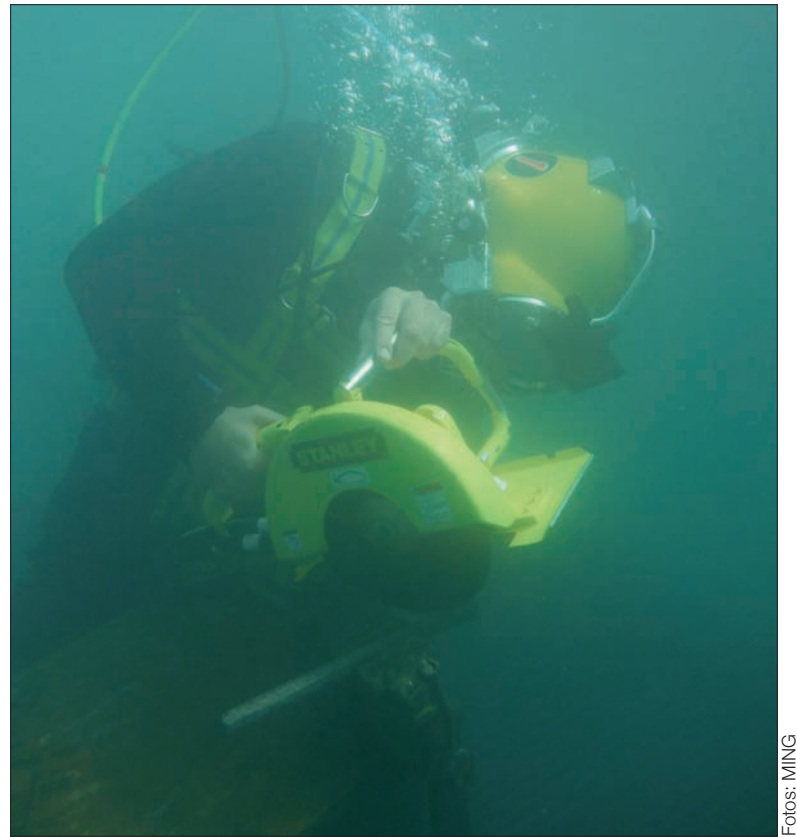
Trabajos subacuáticos con equipo de suministro desde superficie
