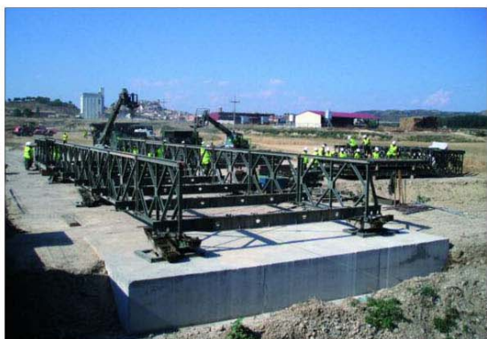
La Compañía de Puentes de Apoyos Fijos se encargó del montaje y desmontaje
