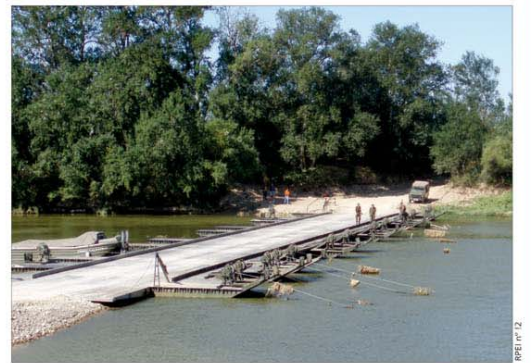
El puente tiene 90 metros de longitud y está sujeto mediante cabestrantes
