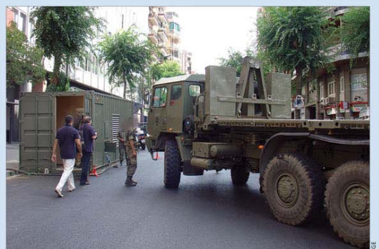
Los generadores se instalaron en diferentes calles de la ciudad
