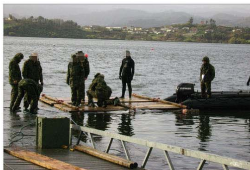
El núcleo de Zapadores construyó una compuerta y una rampa de acceso
