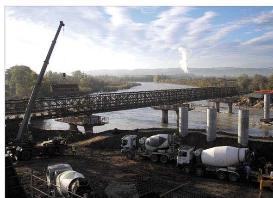
El puente está articulado en cuatro tramos y tiene una longitud de 120 metros
