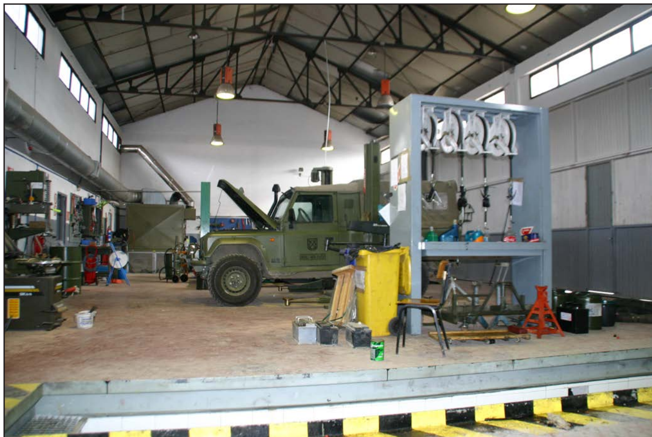
Instalaciones de la Unidad de Servicios de la Base Araca
