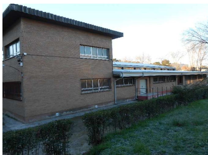
Edificio Antigua Imprenta C/ Clara Campoamor, 2 bis
