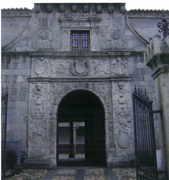
IMAGEN DE LA FACHADA PRINCIPAL
