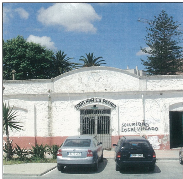
Fachada de la Panadería Militar
