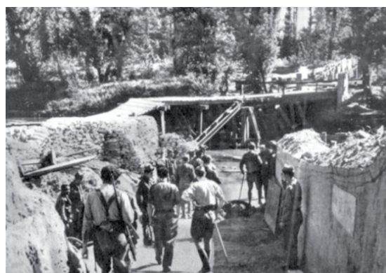
En primer término un pilar en la margen izquierda y al fondo el arco de acceso al puente, el cual se realizaba por debajo de la tapia
