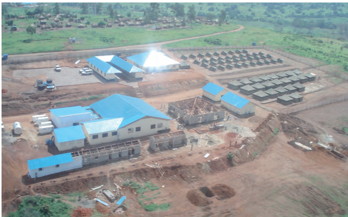
Vista aérea de la zona de vida del personal de EUTM en el campo de entrenamiento de Bihanga en la que se observan las obras en curso y las tiendas utilizadas como alojamiento durante la primera fase de la misión
