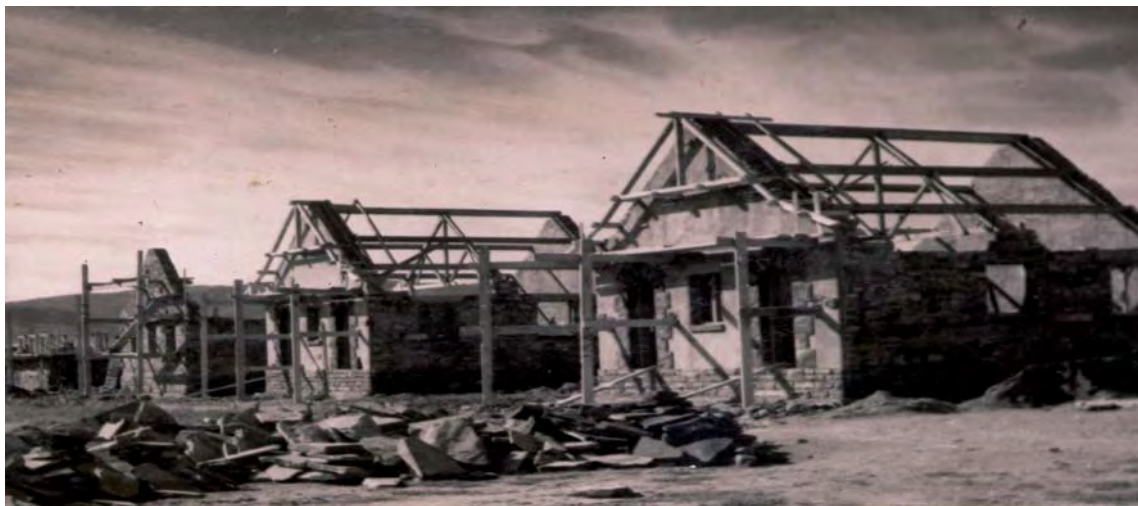
Construcción de la EMMOE
