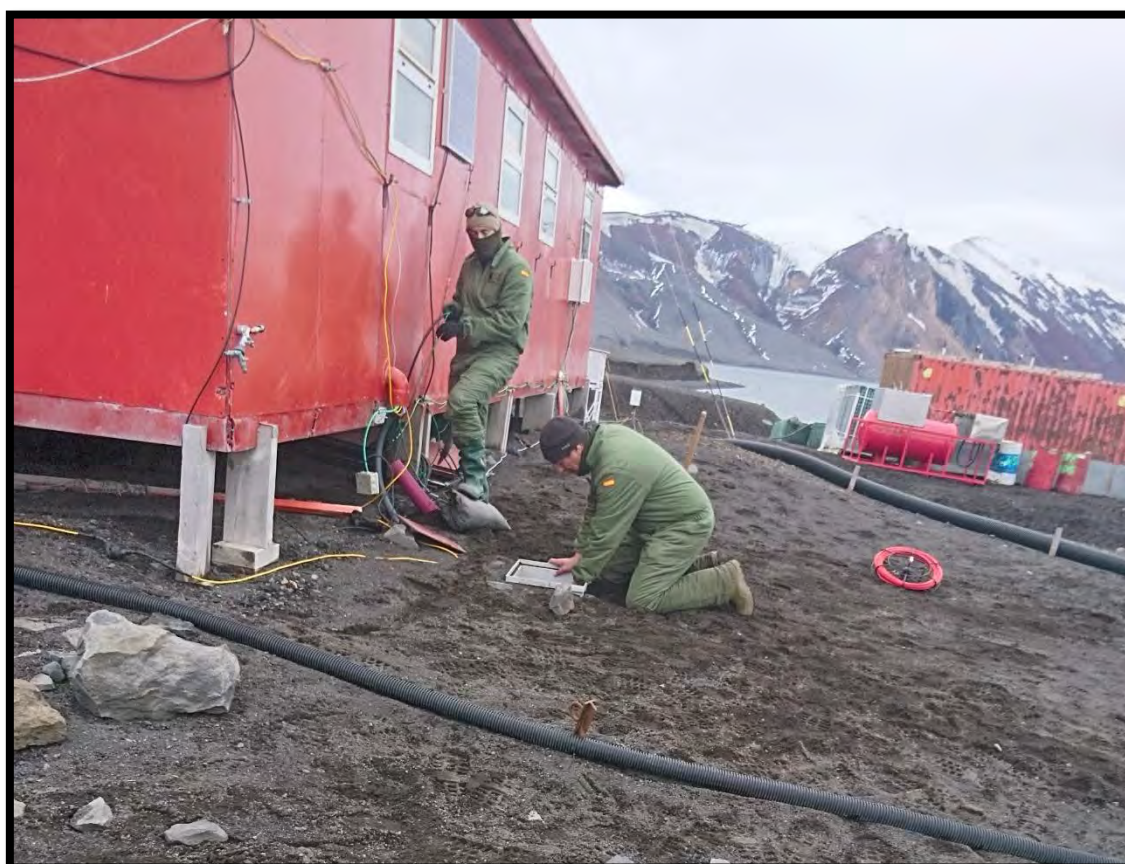
Instalación de FO (fibra óptica) en el Módulo Científico
