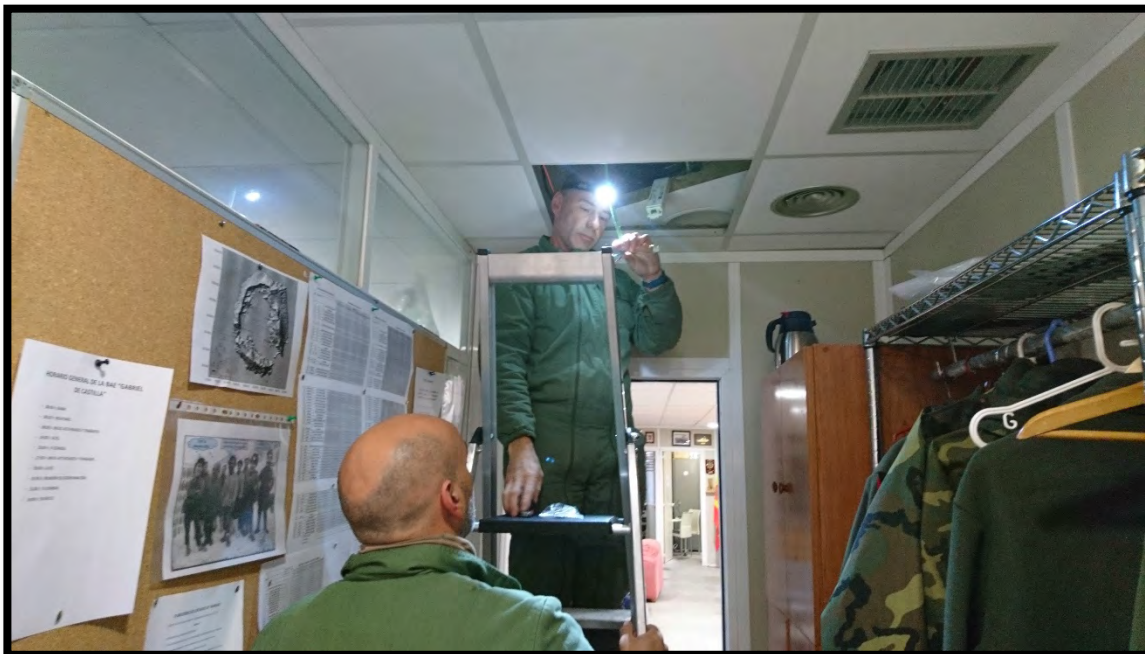
Trabajos de mantenimiento en el módulo de vida (instalaciones)
