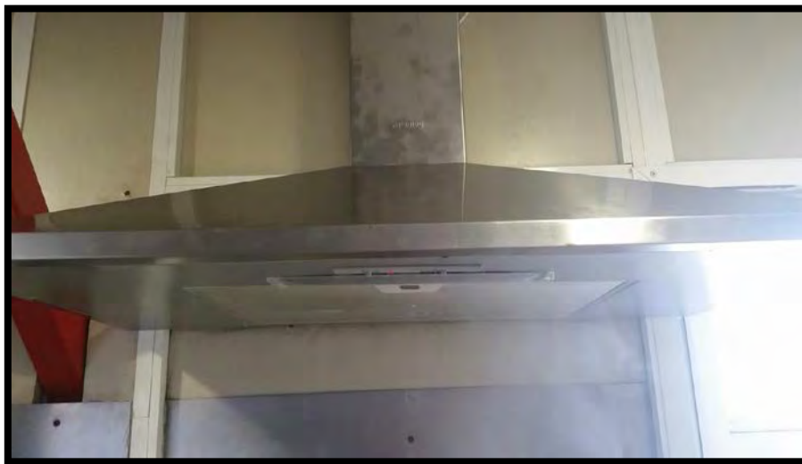
Instalación de campana extractora
