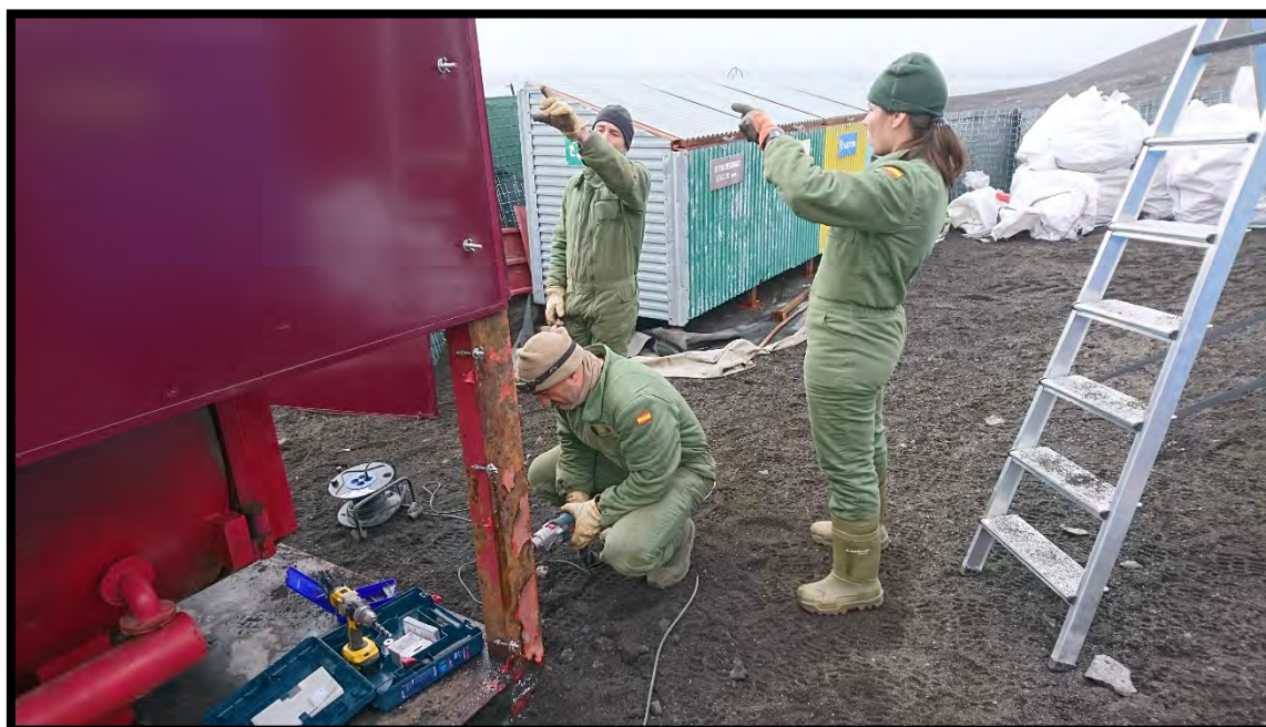
Trabajos en la incineradora
