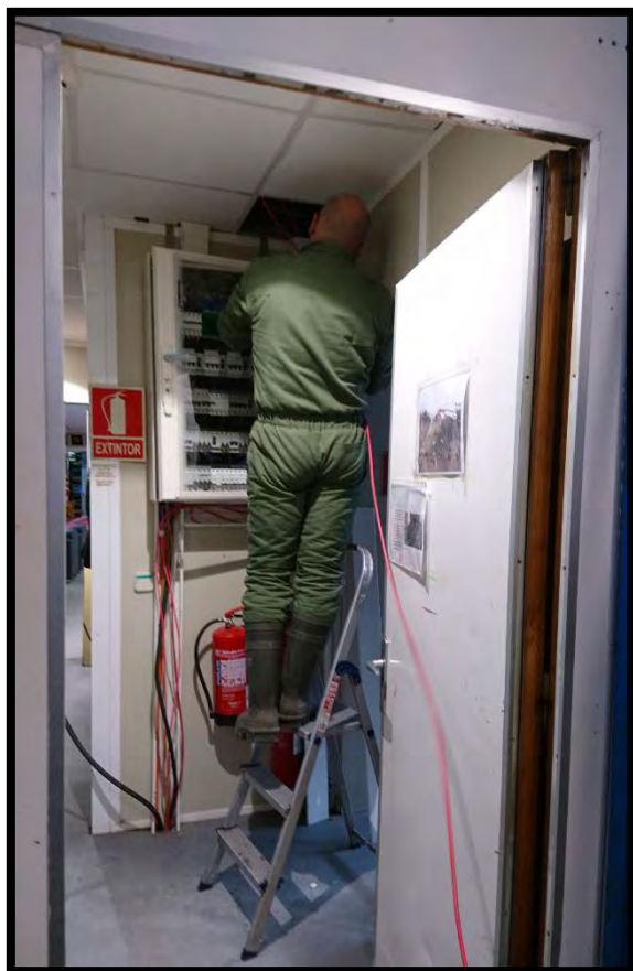
Saneamiento instalación eléctrica área de instalaciones
