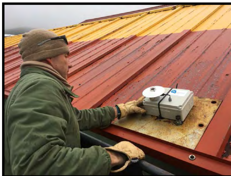
Colocación de captadores solares en el techo del módulo de vida
