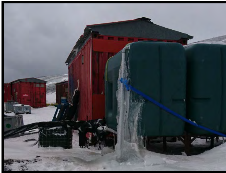
Formación de hielo en los depósitos de agua y situación del Cráter Zapatilla
