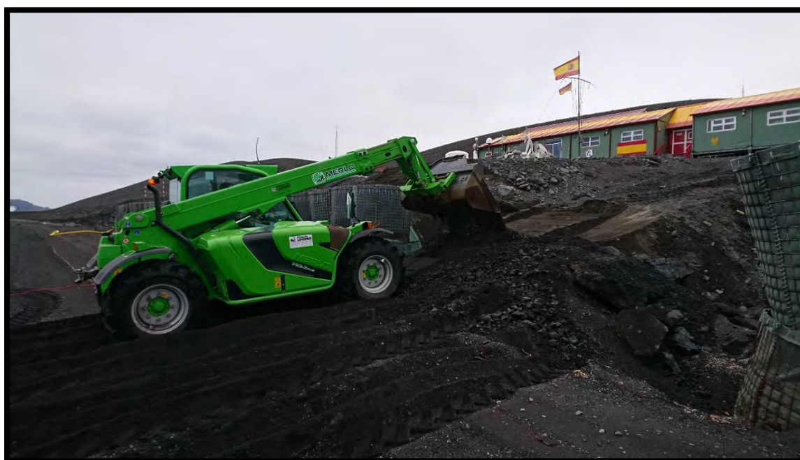
Acondicionamiento de la rampa de acceso
