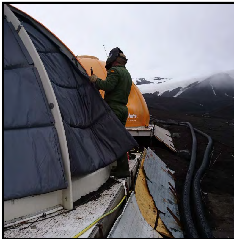
Reparación del iglú de fibra
