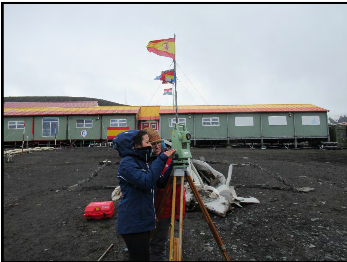
Nivelación en la zona de la playa
