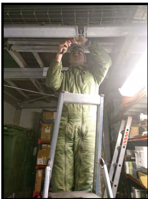
Instalación de iluminación en módulo almacén
