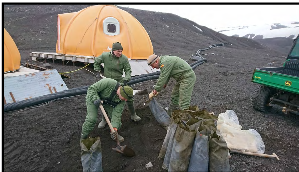
Llenando sacos terreros
