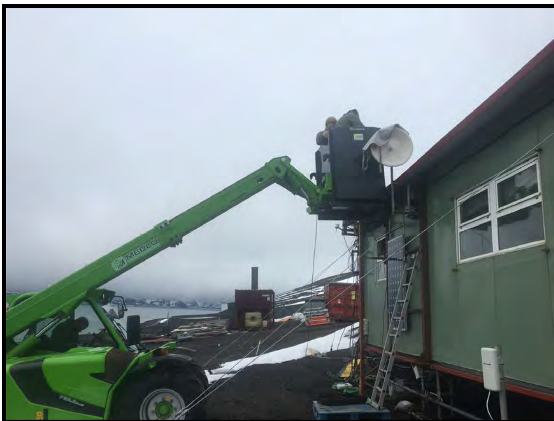
Instalación de antena en el módulo de vida
