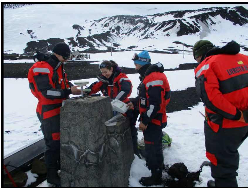
Instalación estación GPS en Bahía Teléfono
