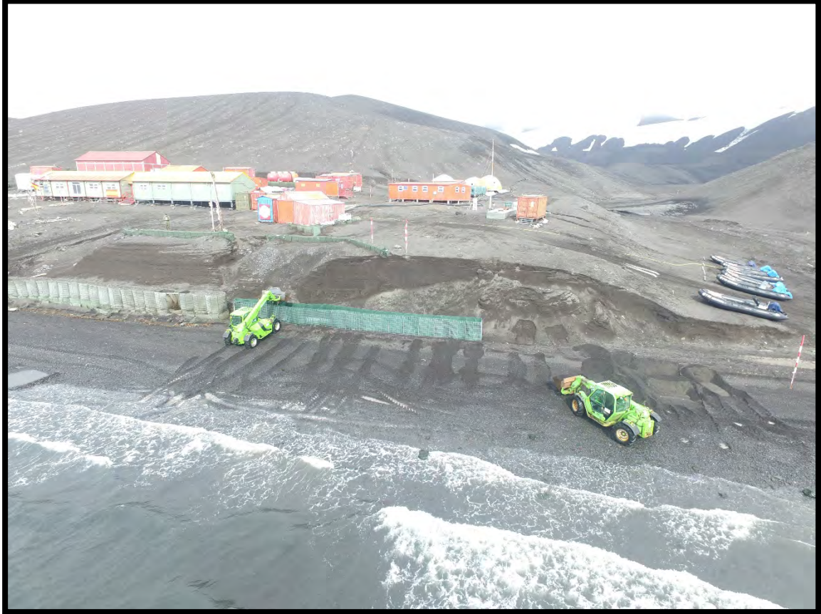
Imágenes captadas por el dron con las Merlo trabajando en el frente de costa
