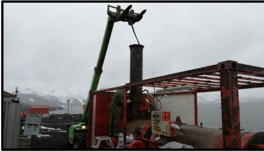
Reparaciones en la Incineradora
