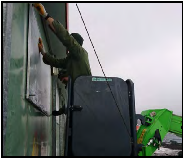
Colocando los paneles en las ventanas del módulo de vida
