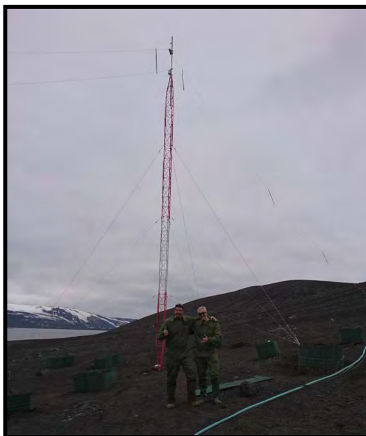
Instalación de la antena HF de casi 14 m de altura con el quipo CIS de la dotación. Esta antena se retirará durante la invernada,
