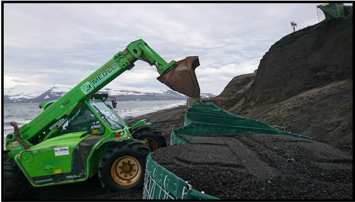
Emplazamiento de gaviones en la línea de costa
