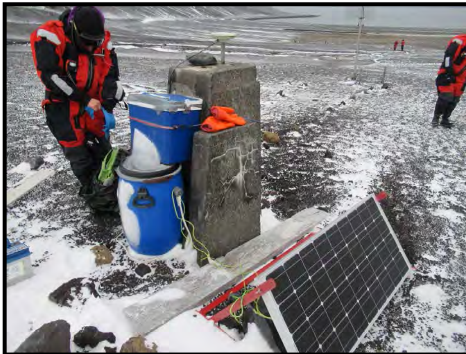
Trabajos en CR 70
