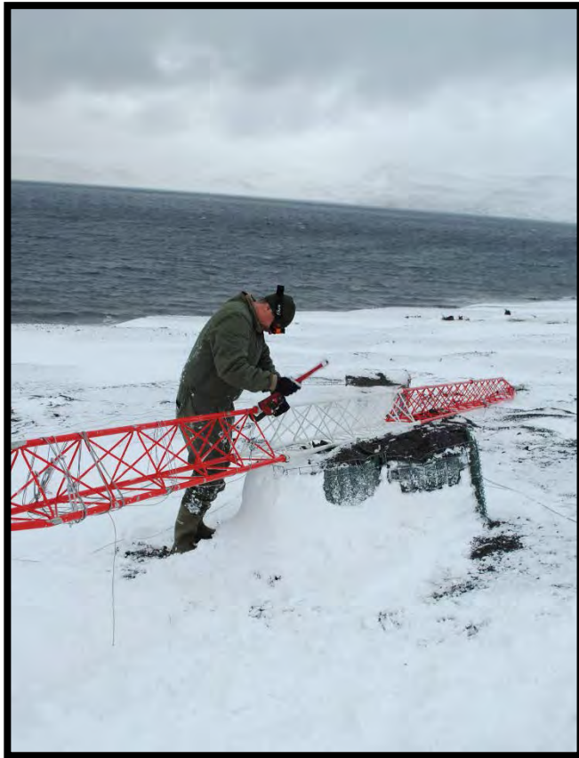
Desmontaje antena HF
