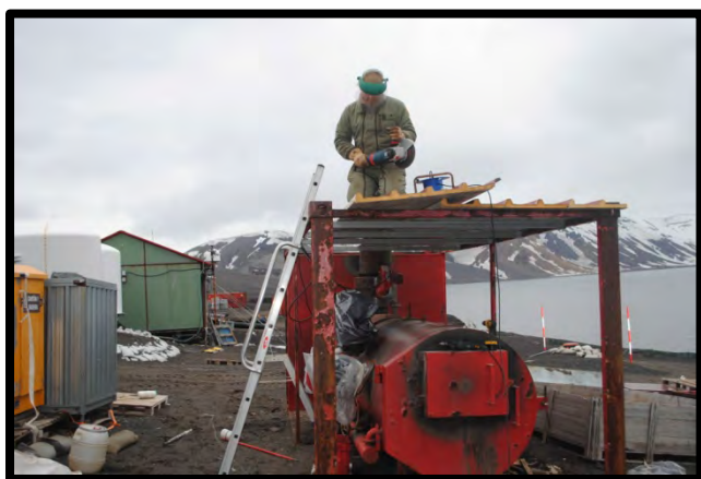
Instalación chasis de la Incineradora
