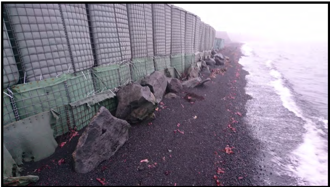
Para mejorar la acción de los gaviones se ha reforzado con rocas
