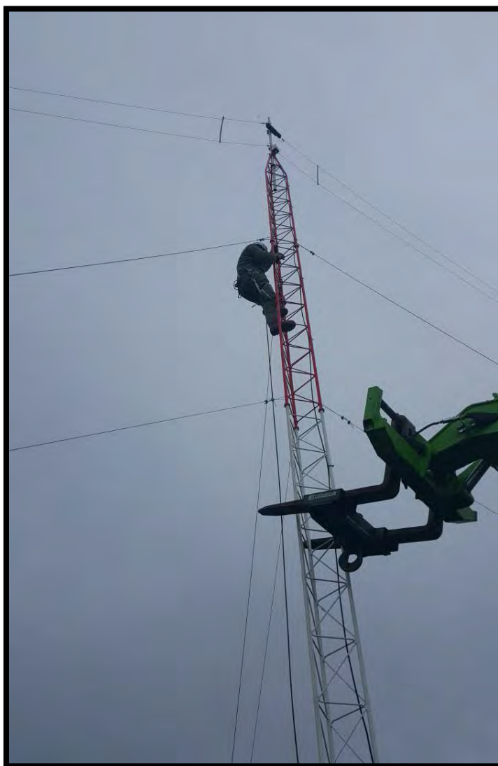
Trabajos en altura antena HF
