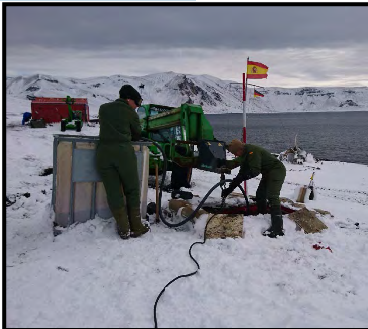
Extracción de lodos de la fosa séptica
