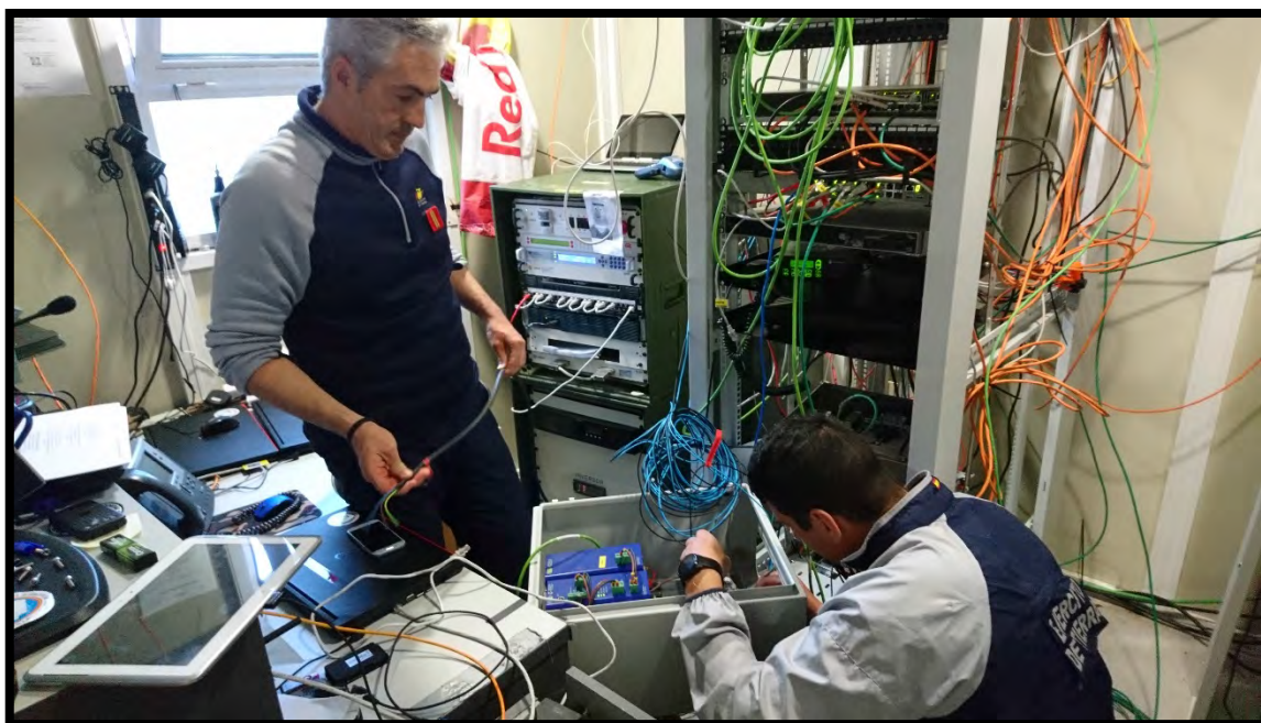
Mejora infraestructura CIS de la base.
