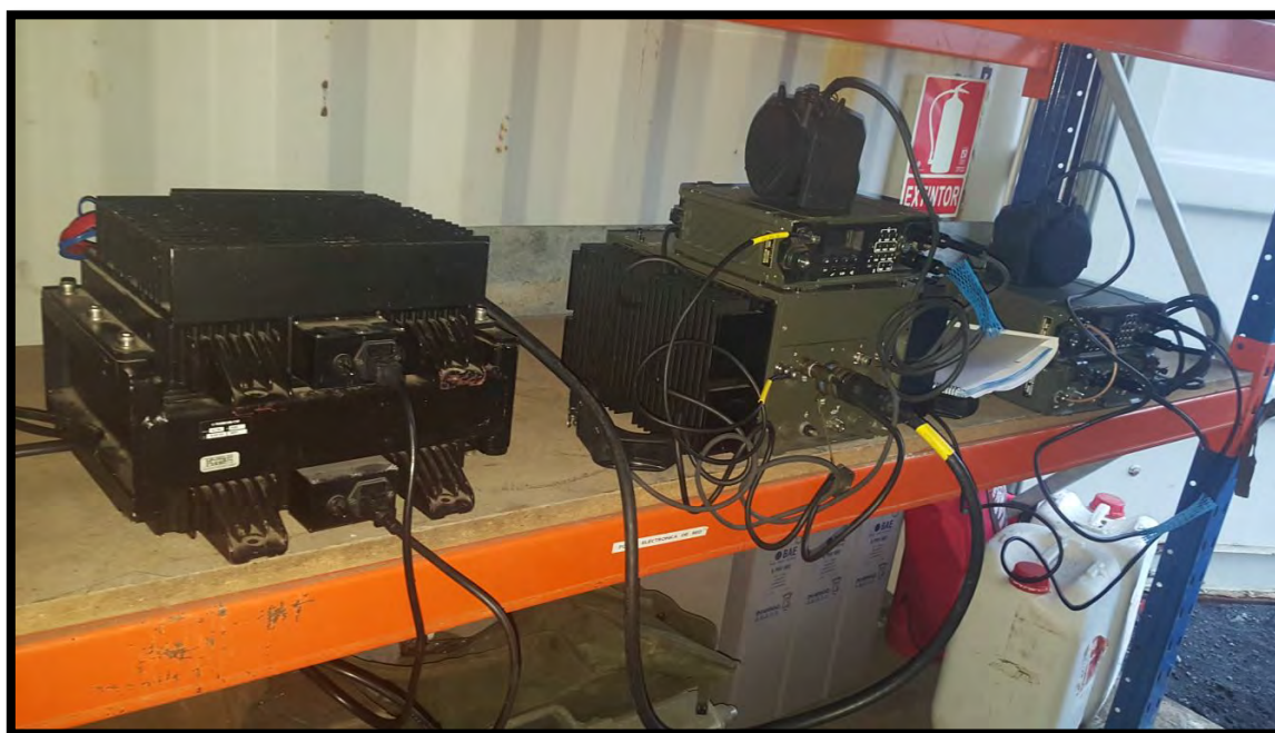
Instalación de terminales HF
