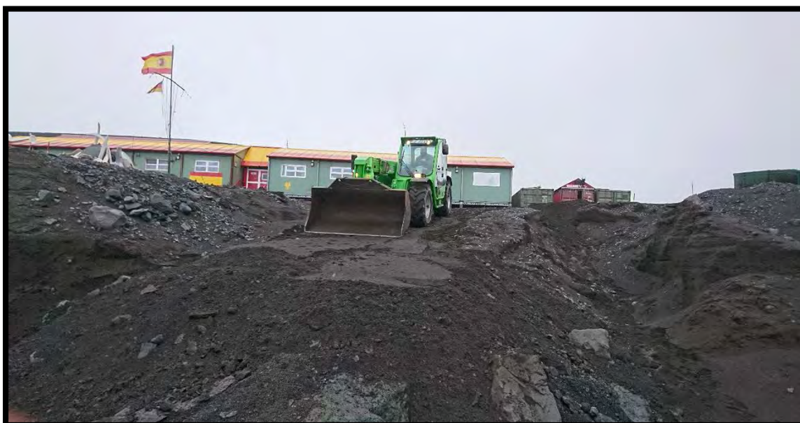
Acondicionamiento de la rampa
