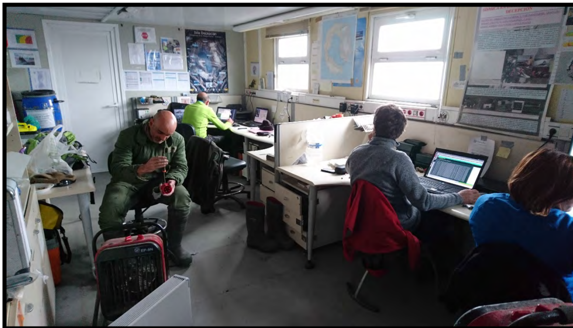
Reparación de un calefactor en el módulo científico
