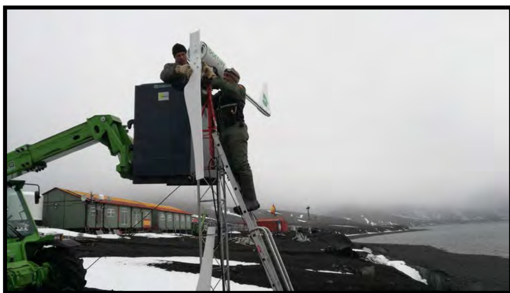
Instalación del nuevo aerogenerador
