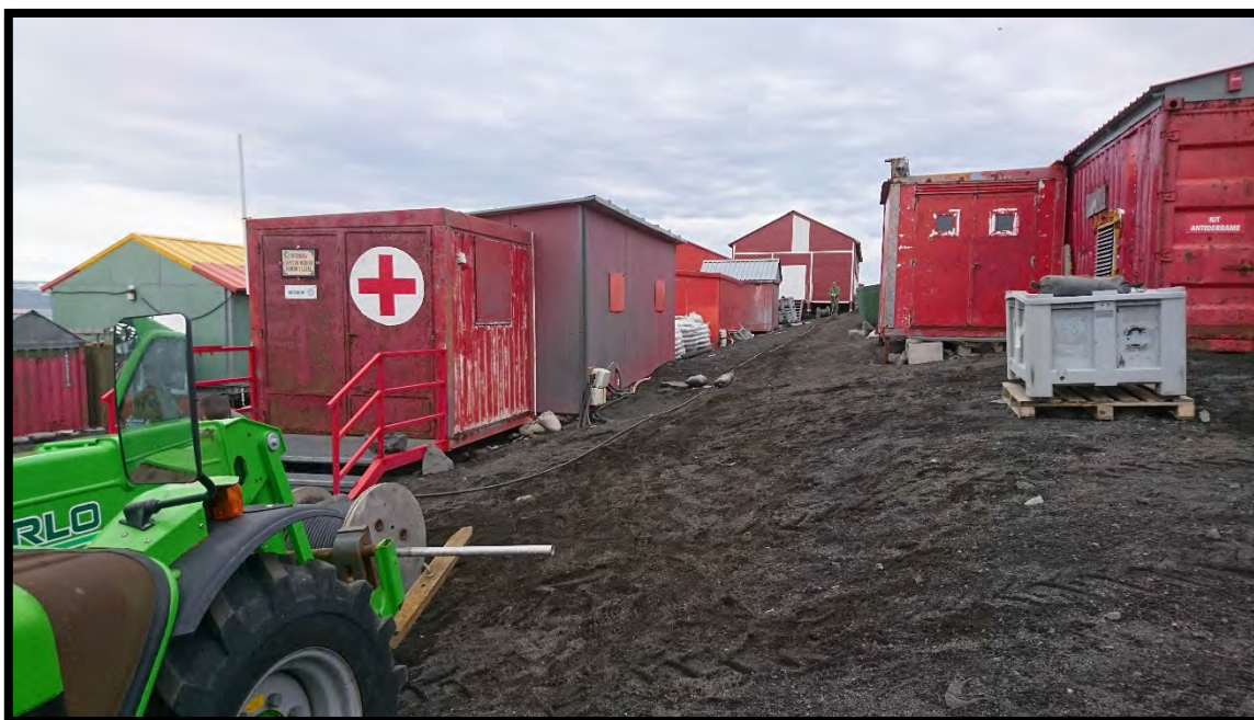
Tirando nuevo cable eléctrico
