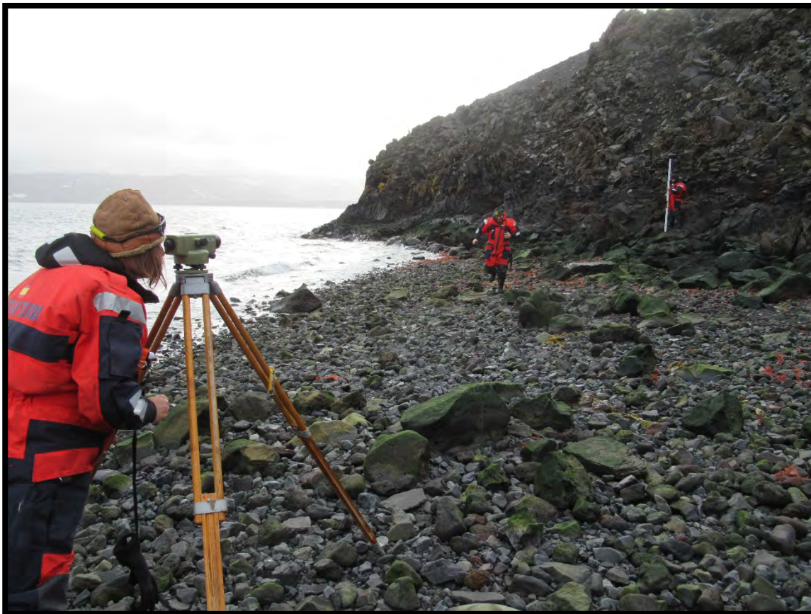
Trabajos topográficos en Colatinas
