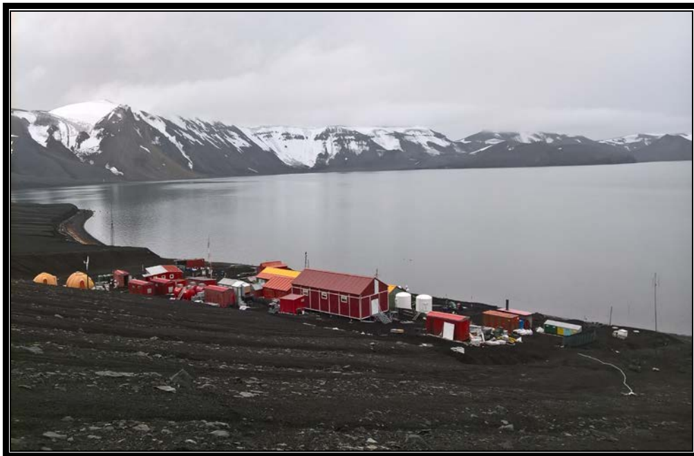
El almacén ya domina la imagen de la Base..
