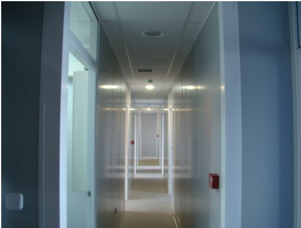
Vista del pasillo central tras la finalización de la instalación del falso techo del módulo dormitorio.
