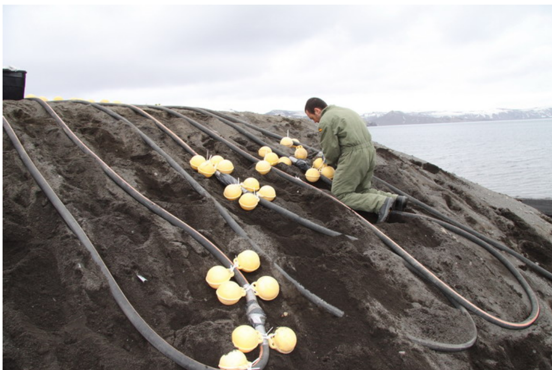
Tareas de preparación de la manguera para las operaciones de combustible previstas para principios de enero.
