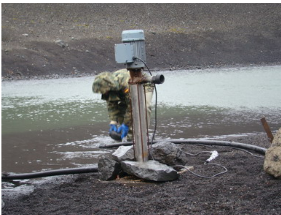
Tareas de reparación en el sistema de recepción de agua para el suministro de la BAE. Isla Decepción, 17 de febrero de 2009. El Comandante Jefe de la Campaña.
