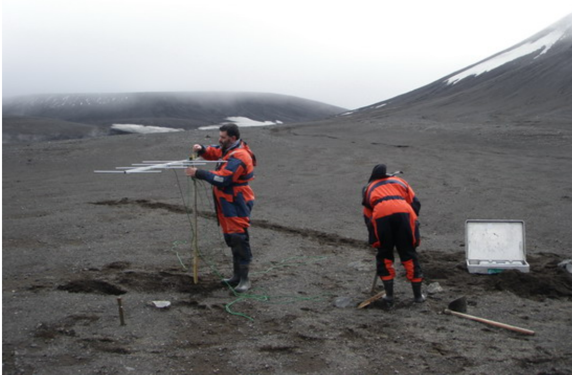
Instalación de telemétrica en la estación de Obsidianas.
