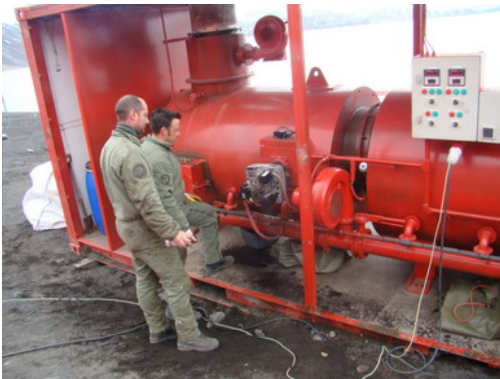
Trabajos de mantenimiento del quemador de la incineradora.
