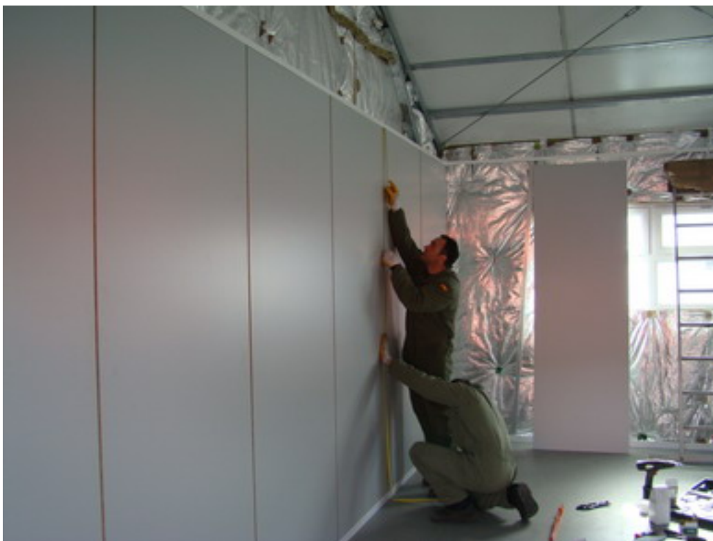
Trabajos para el panelado del perímetro interior del módulo dormitorio.
