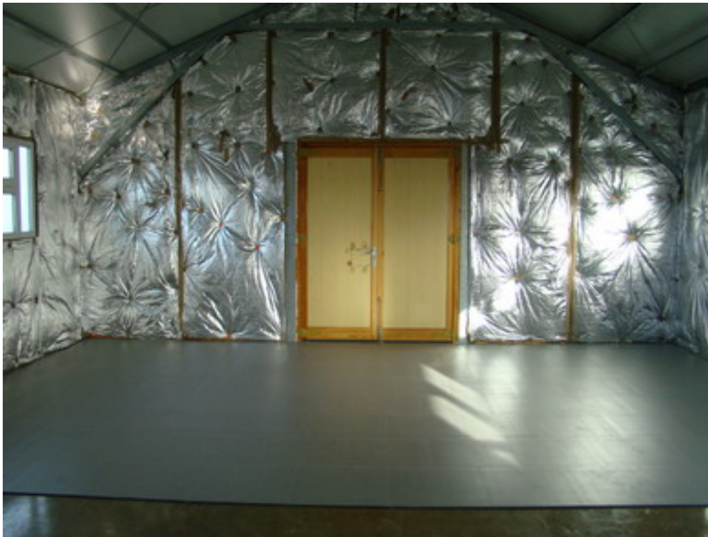
Instalación del suelo definitivo en el módulo dormitorio.
