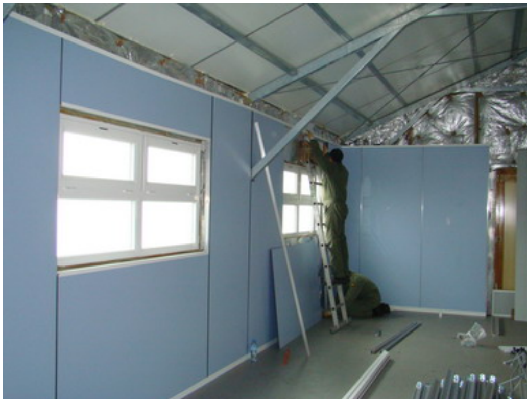
Trabajos de colocación del panelado definitivo sobre paredes y aseos del interior del módulo dormitorio.
