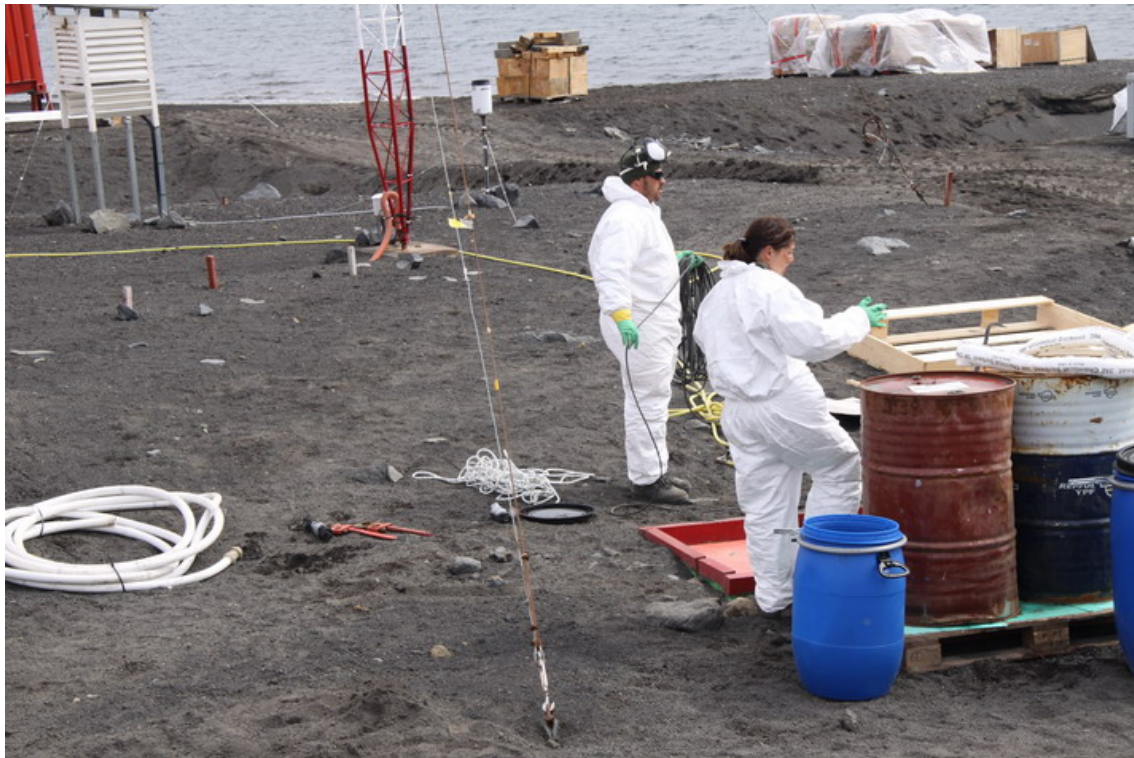
Vaciado de fosas sépticas y separador de grasas
