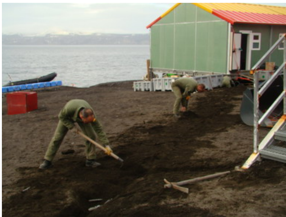
Trabajos de instalación de nuevo circuito de recirculación de agua en el interior de la BAE.
