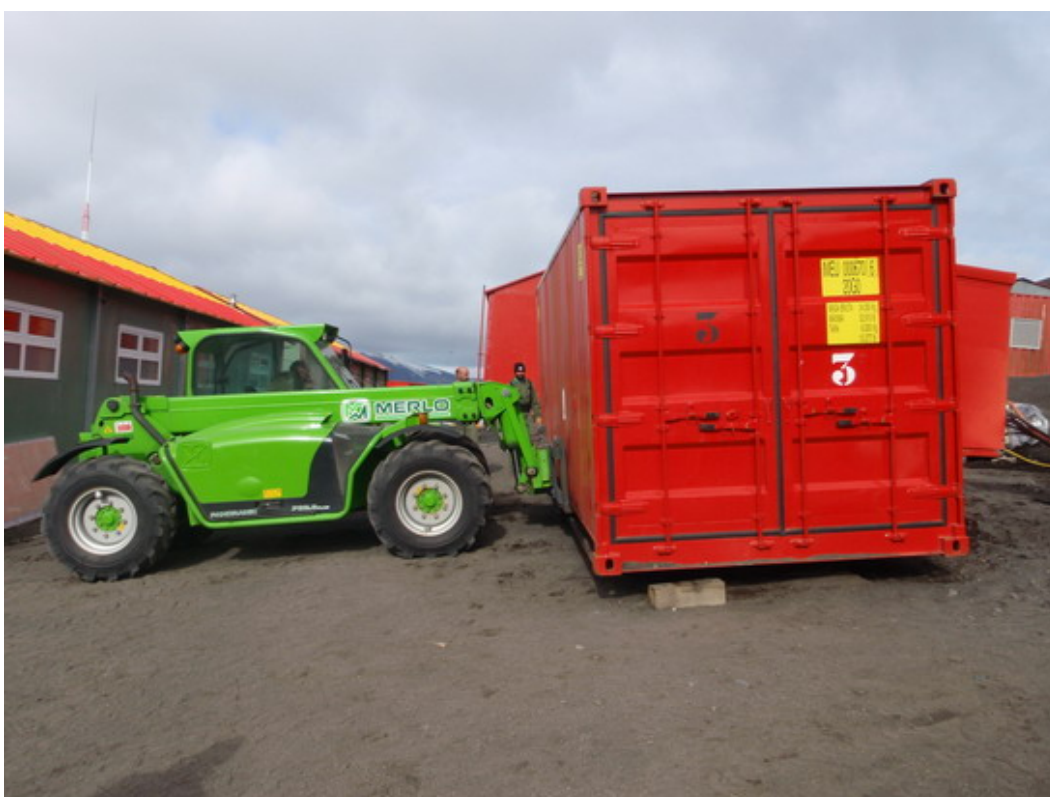
Trabajo de la MERLO para situar el contenedor de 20 pies como nuevo módulo de emergencia.
