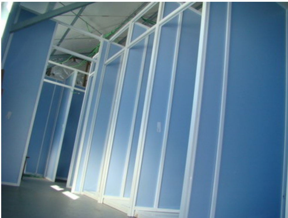
Aspecto que presentan las nuevas duchas del módulo dormitorio.
