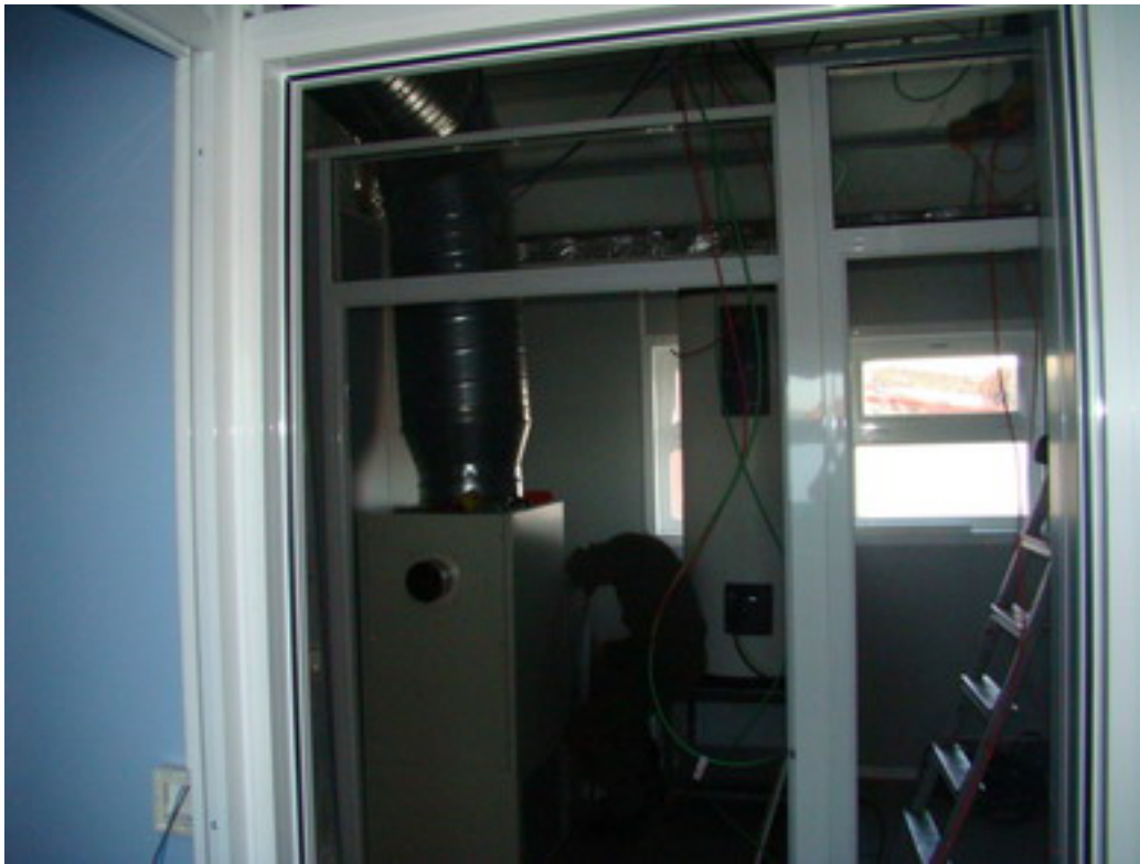
Trabajos en la caldera y el sistema de detección de incendios del módulo dormitorio.
