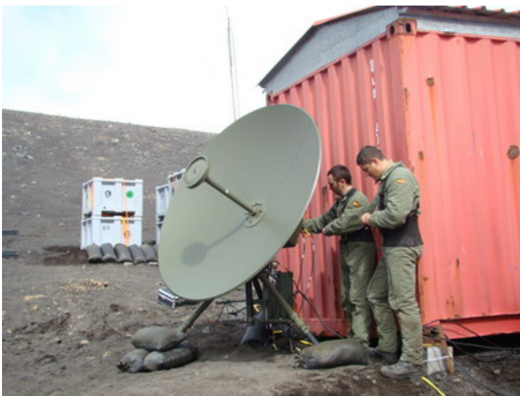
Tareas de colocación del Terminal satélite TLB-50 para ampliar las comunicaciones de la BAE.
