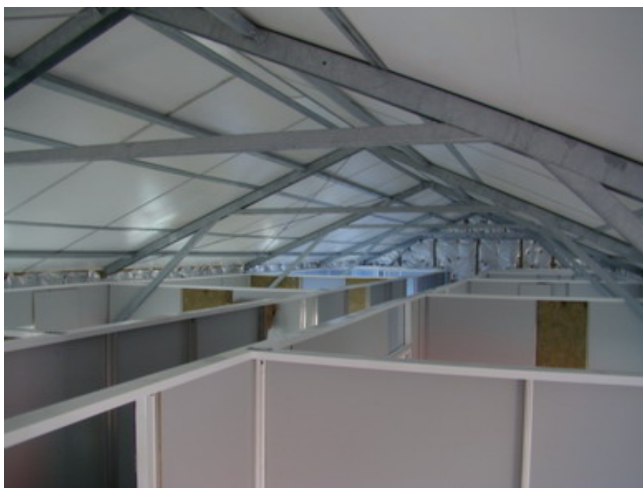
Estado del tabicado interior del módulo dormitorio en la que una vez instalado una fila de paneles se ha comenzado a poner el aislante intermedio a la segunda cara vista del panel.
