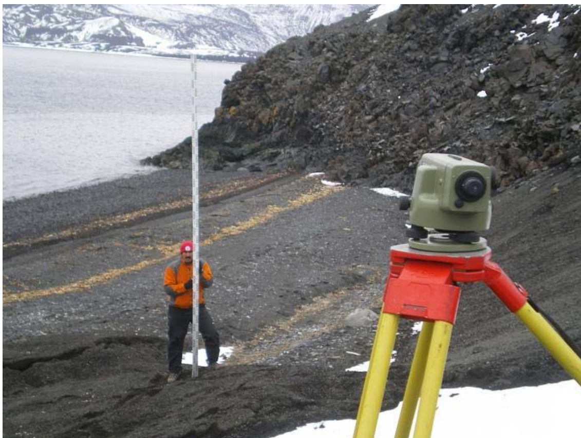
Trabajos de nivelación del proyecto SEGAVDEC-GEO en la zona de Colatinas.
