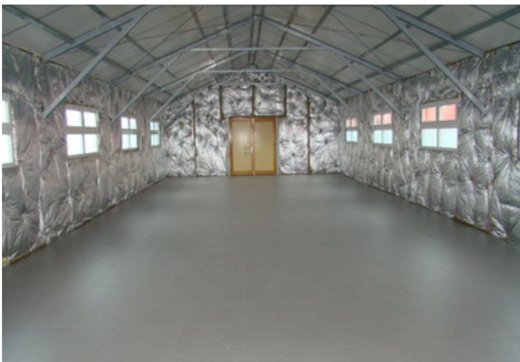
Por la tarde han finalizado las tareas de colocación del suelo definitivo del módulo dormitorio.
