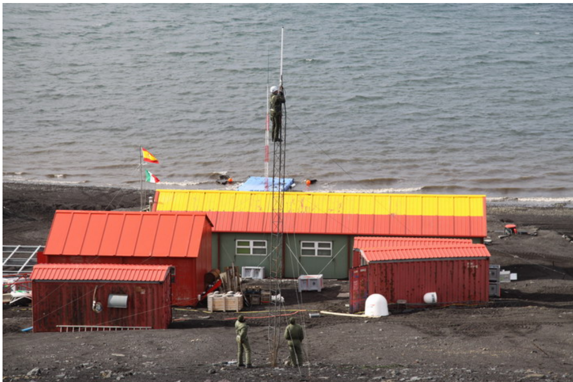
Instalación de antena de VHF.
