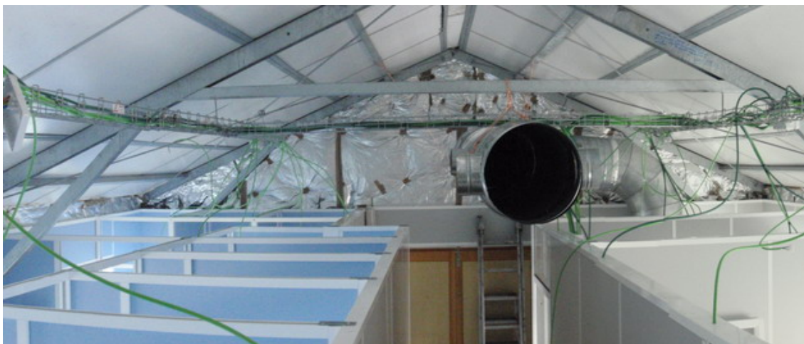
Trabajos montaje del sistema de calefacción del módulo dormitorio.
