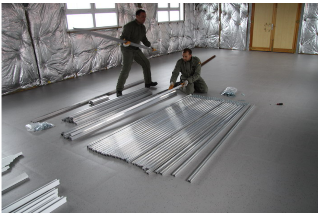
Trabajos de colocación de perfilaría sobre la que se montarán los paneles y tabiques interiores del módulo dormitorio.
