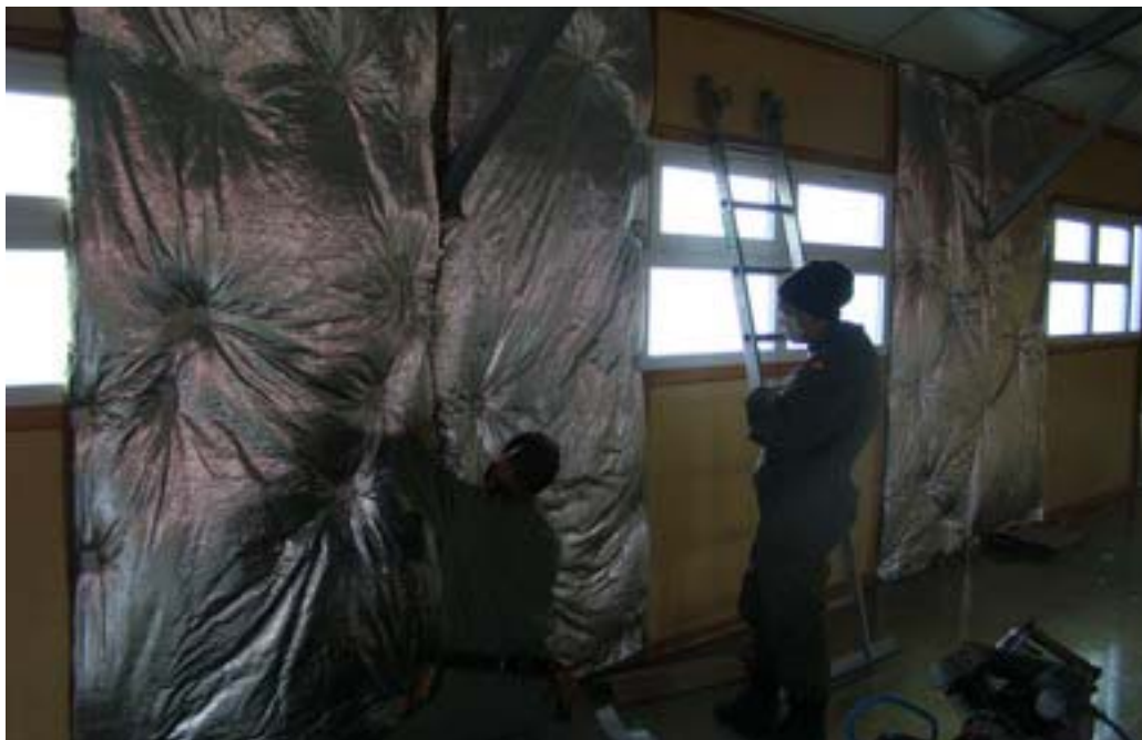
Colocación del aislante que cubrirá el interior de las paredes del nuevo módulo de vida.
