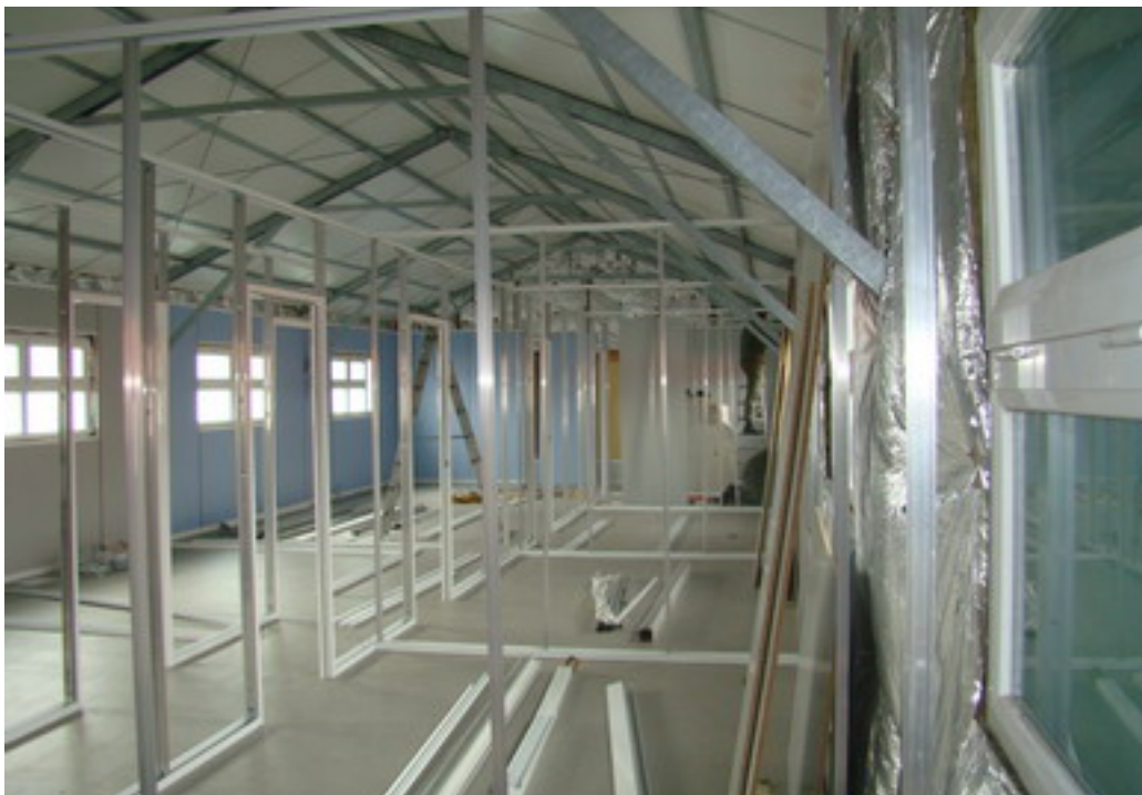
Aspecto de la estructura para colocar el panelado interior, con la separación para las habitaciones, aseos, caldera y cuarto de lavadora y secadora.
