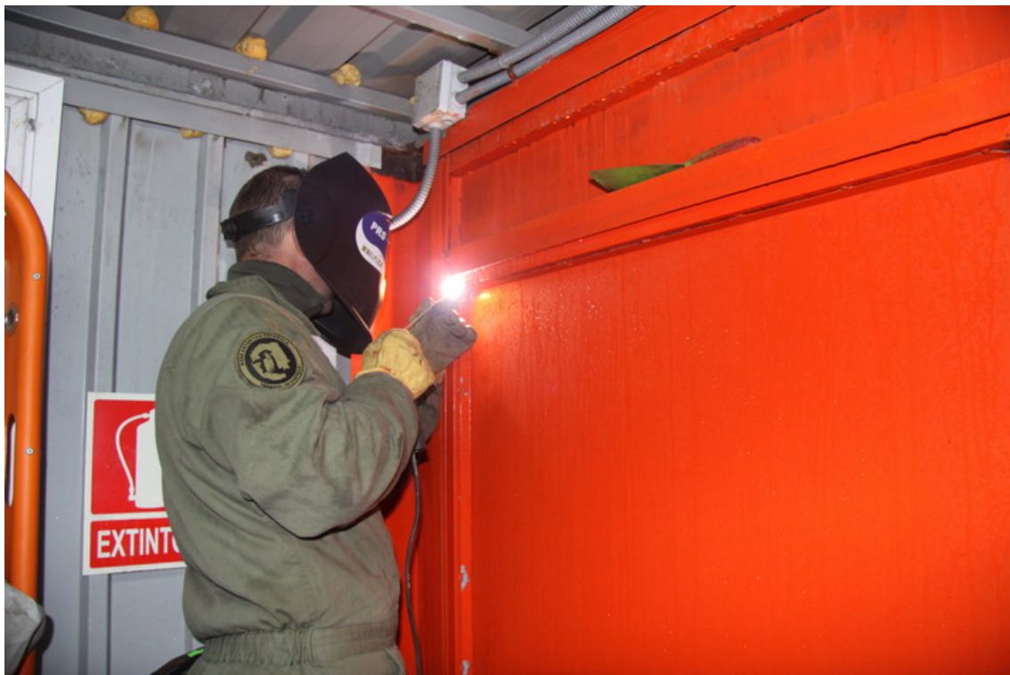
Tareas de reparación en la puerta del módulo de enfermería de la BAE.
