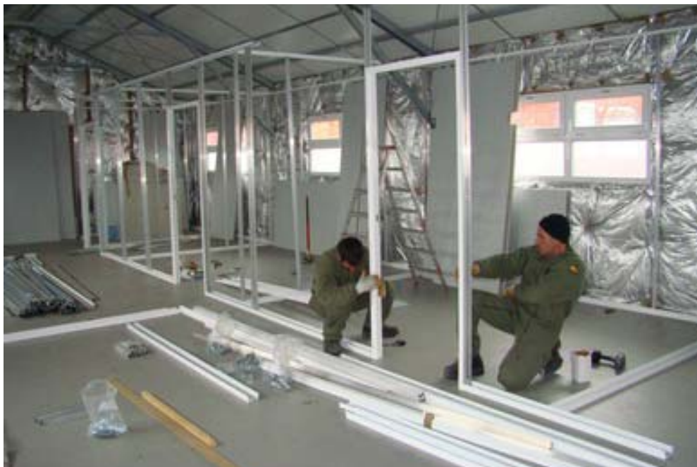
Trabajos de colocación de la estructura sobre la que se montará el panelado interior del módulo dormitorio.
