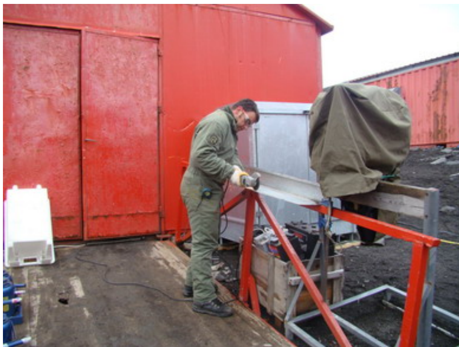
Trabajos para la confección del alero del tejado del módulo de obras.
