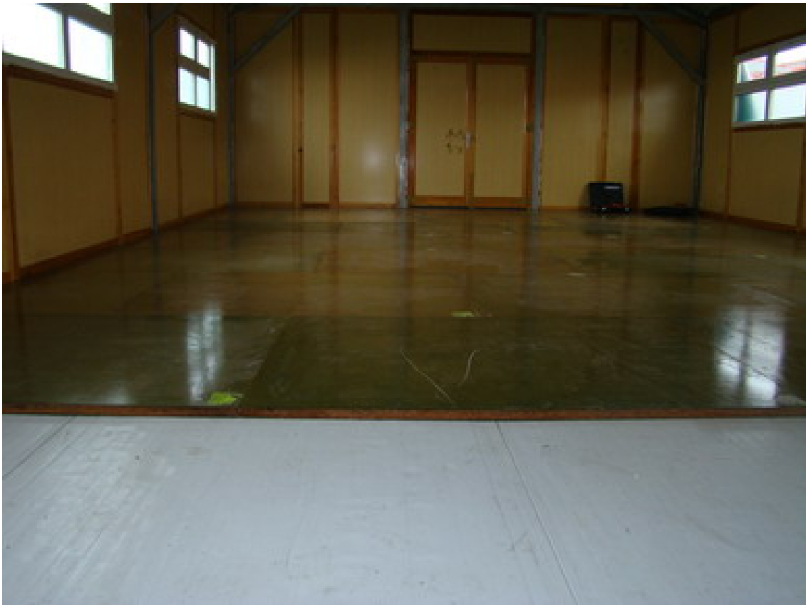
Proceso de montaje del suelo de madera del módulo dormitorio.
