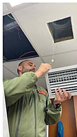
TRABAJOS EN MODULO DORMITORIO
