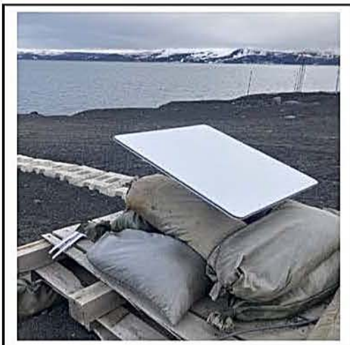
INSTALACION TERMINAL STARLINK
