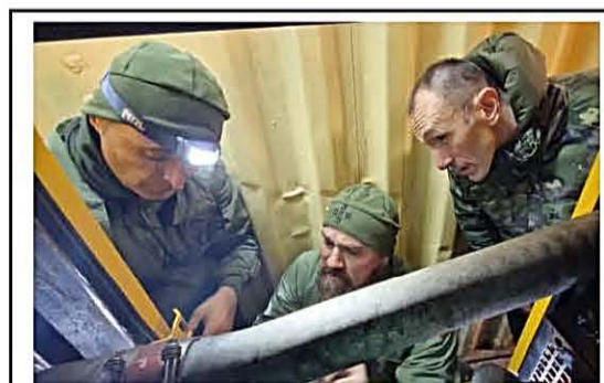
INSTALACION DEL TURBO
