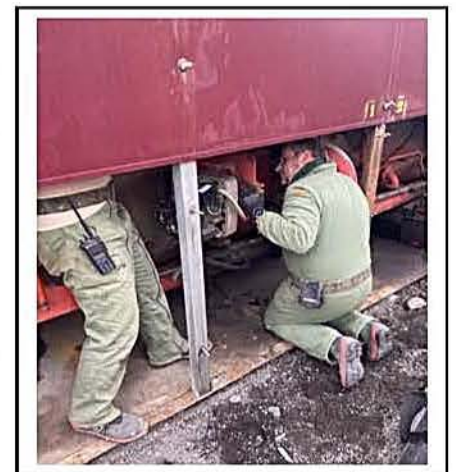
REPARACION DE INCINERADORA
