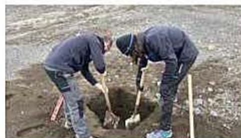
ADECUACION DE TERRENO PARA AEROGENERADOR
