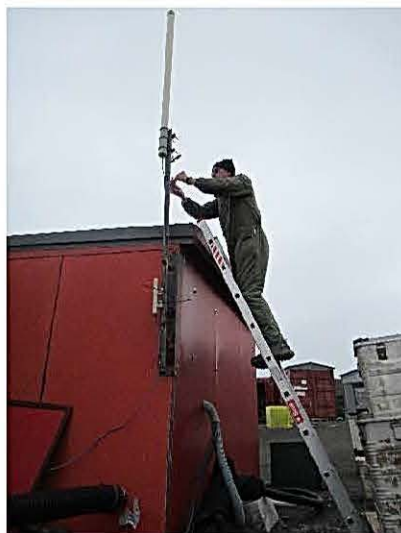
TRABAJOS ADECUACION DE ANTENA
