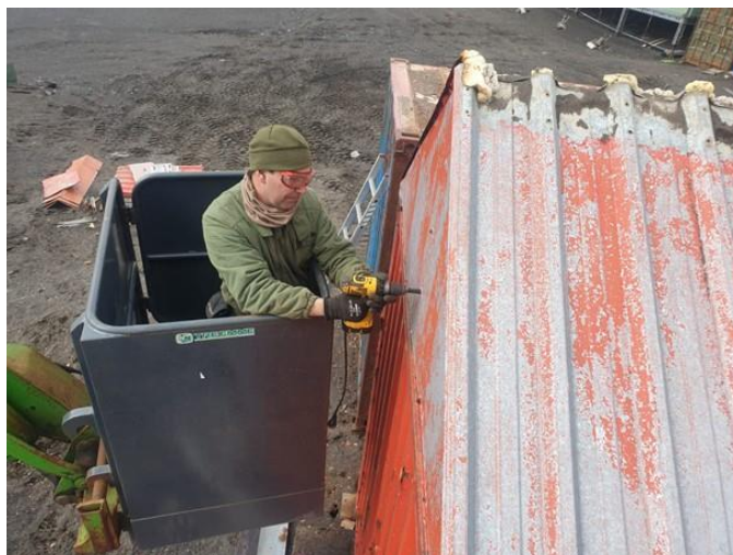
Revestimiento de contenedores
