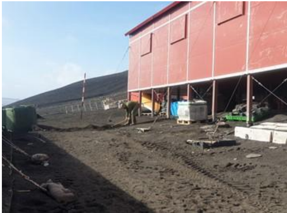
Mejora en el enterramiento de cableado
