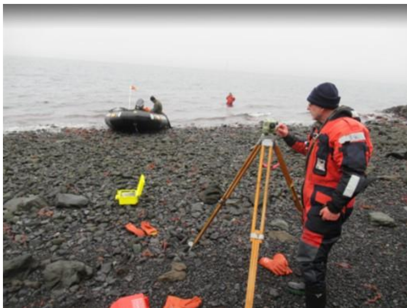
Instalación regla de mareas
