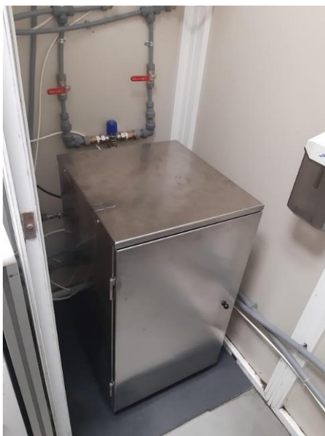
Nueva planta potabilizadora en zona de vida
