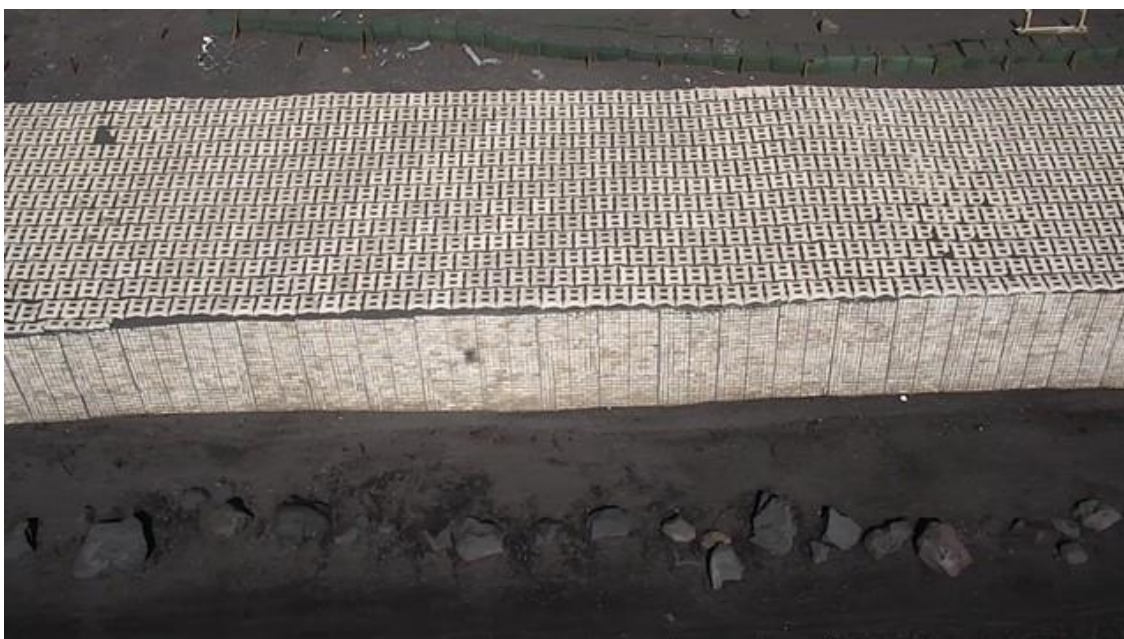
Vista del muro realizada con el dron
