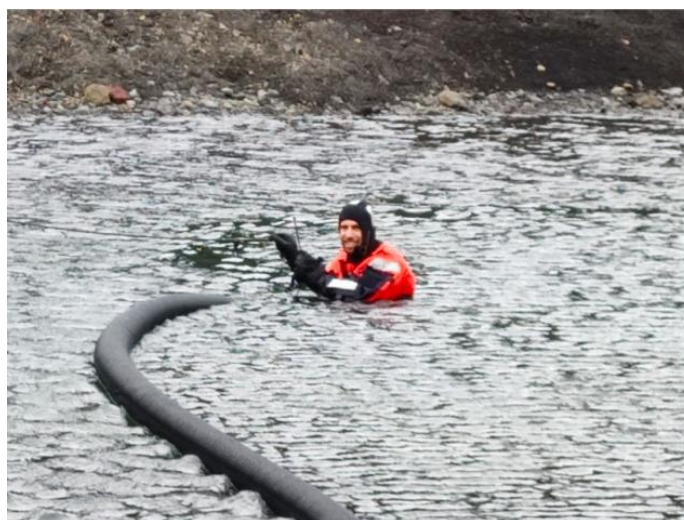
Instalación agua en lago "Zapatilla"
