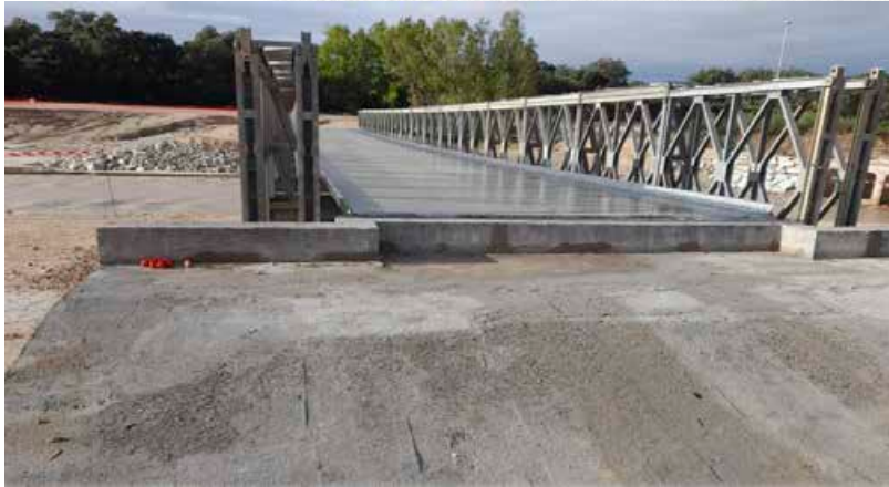
Ilustración 12. Construcción de la cuña de transición para las rampas.
