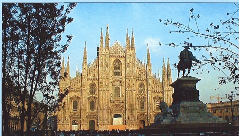
Vista de la fachada de la Catedral gótica de Milán, símbolo de la ciudad
