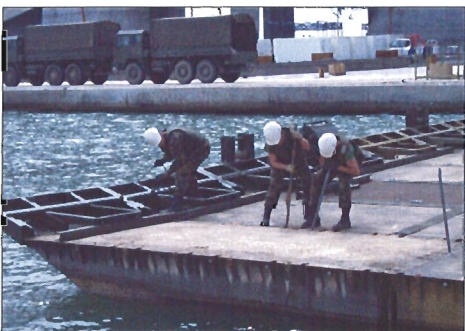
El puente se ha instalado para unir dos partes de la dársena del recinto
