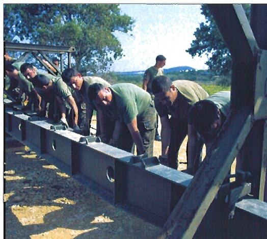
Se realizó un gran esfuerzo para tener el puente montado en el plazo previsto
