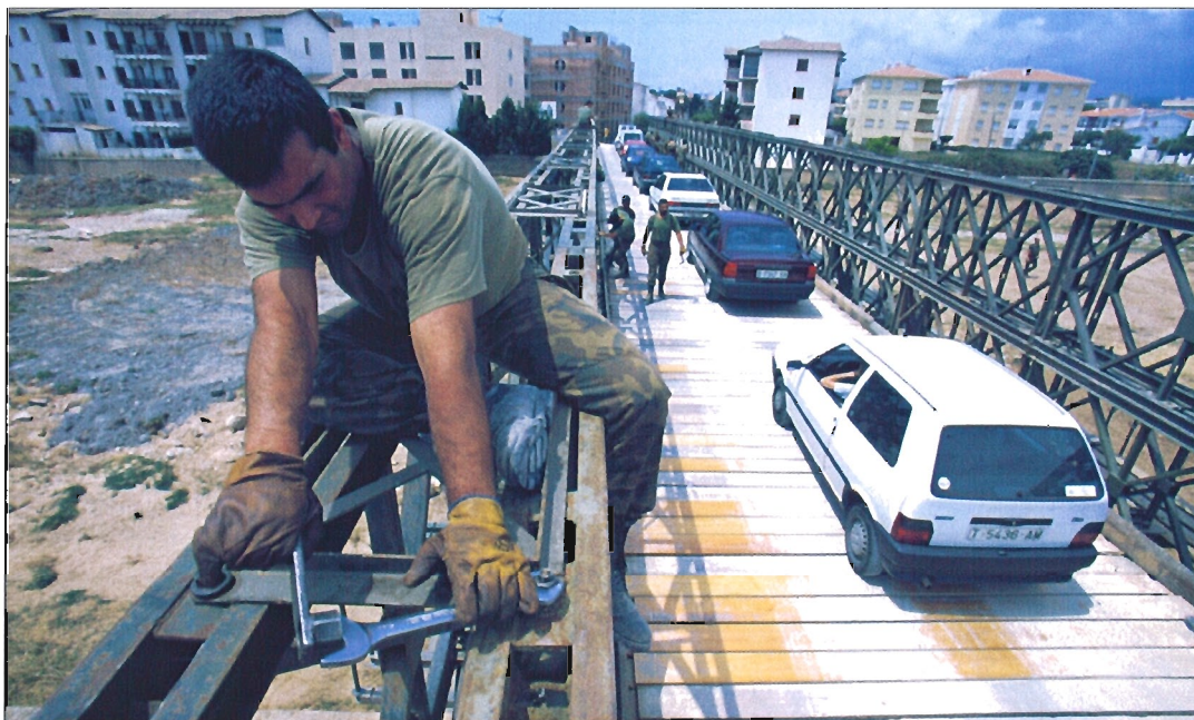
Cada uno de los tramos del puente Bailey tiene una longitud de 54 metros
