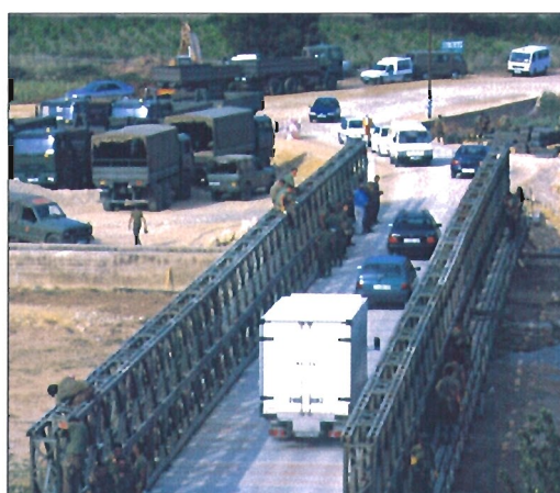
Cada tramo del puente Bailey tiene una longitud de 54 metros
