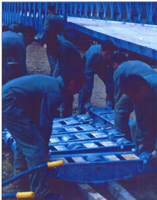
El Mabey puede ser montado con la ayuda de grúas
