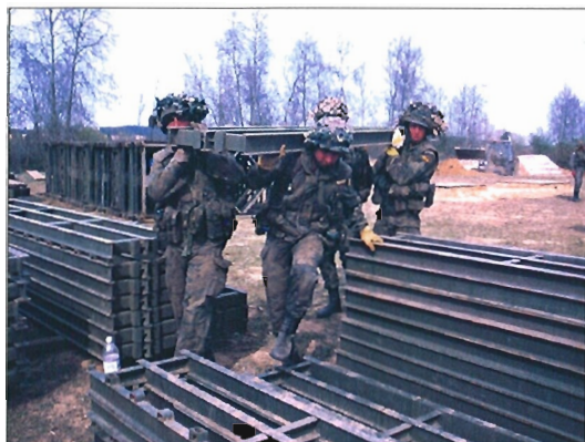
El montaje y el desmontaje del puente Bailey implica una ardua labor
