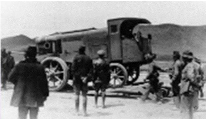
Las ruedas posteriores de éste (motoras) marchan por fuera de la vía de esta manera, se logra que la carga a transportar sea arrastrada sobre carriles, para mayor facilidad en la tracción, mientras que las ruedas tractoras marchan sobre una pista o camino
