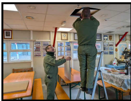
Antonio y Fidel cambiando las luminarias del módulo de vida
