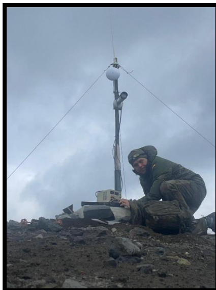
Miguel sustituyendo el repetidor de Cerro Cruz
