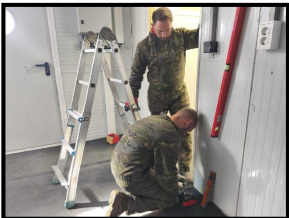
Ernesto y Fran colocando instalando los perfiles de las puertas interiores
