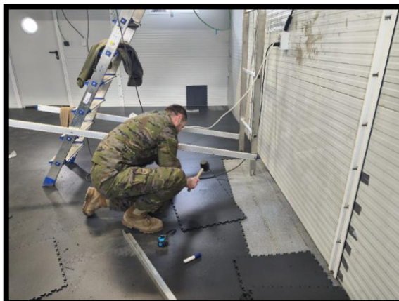
Jesús colocando el suelo del almacén
