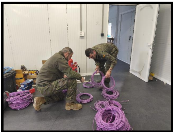
Rubén y Jorge haciendo el replanteo del cableado de datos
