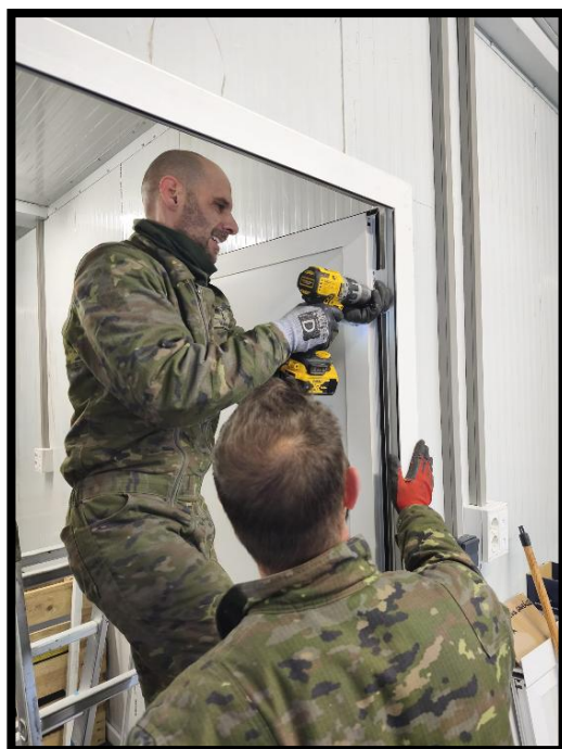
Ernesto y Fran colocando las puertas del modulo
