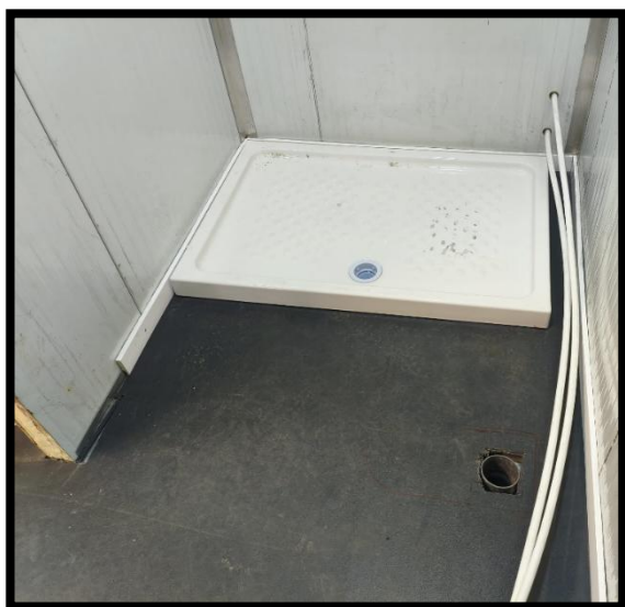
Colocación y sellado del plato de ducha en el aseo
