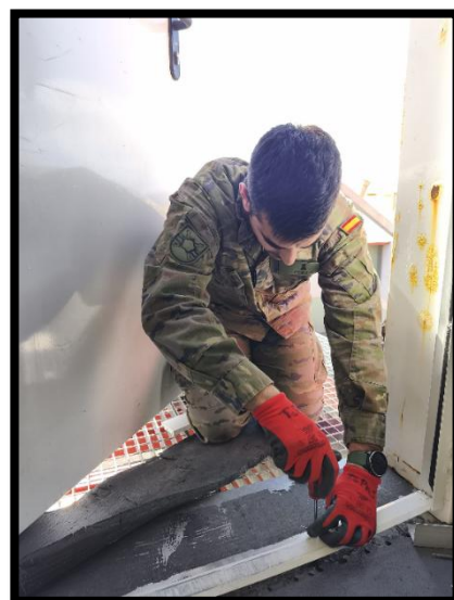
Carlos colocando el vierteaguas de una de las puertas exteriores
