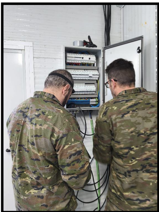
Rubén y Jorge conectando los circuitos en el cuadro general
