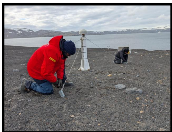
Jorge y Vane tensando los vientos del pilar GNSS de la Estación BASE
