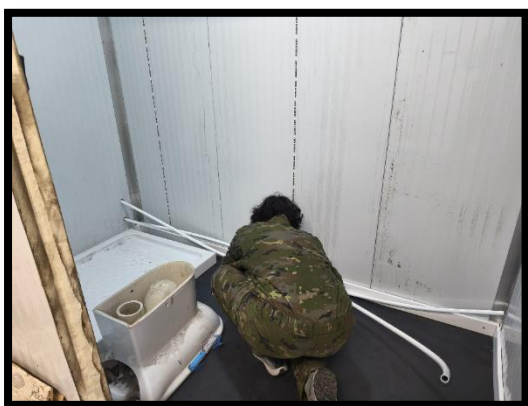
Michelle realizando la bajante del inodoro
