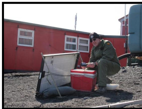
Amós comprobando la placa solar
