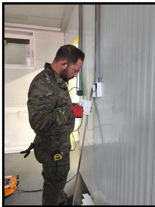
Ernesto colocando los enchufes
