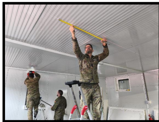
Jorge haciendo el replanteo de las luminarias del laboratorio
