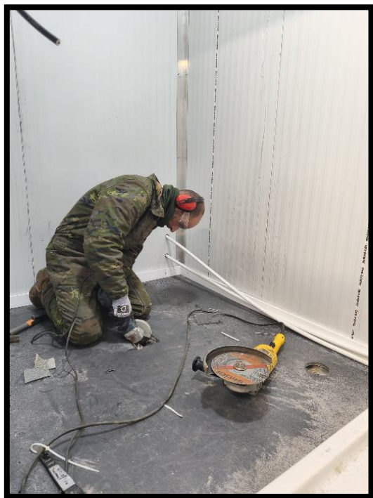
Fran realizando la bajante de la ducha y del inodoro
