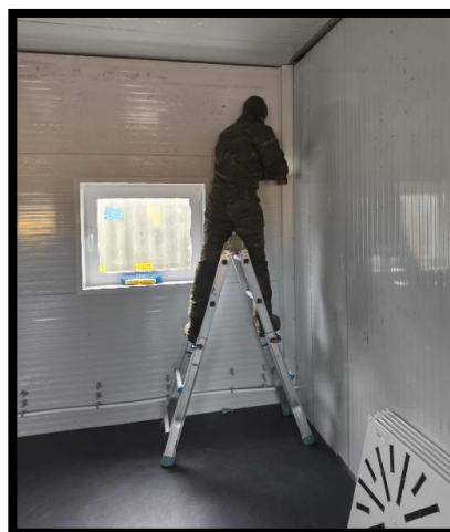
Francisco rematando vigas
