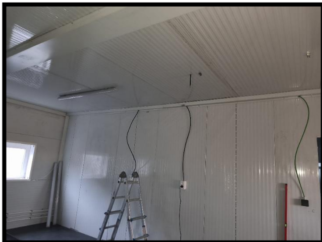
Instalación de red eléctrica en el nuevo módulo científico
