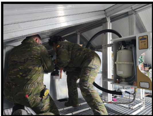
Ernesto y Michelle conectando el humidificador con el fan coil
