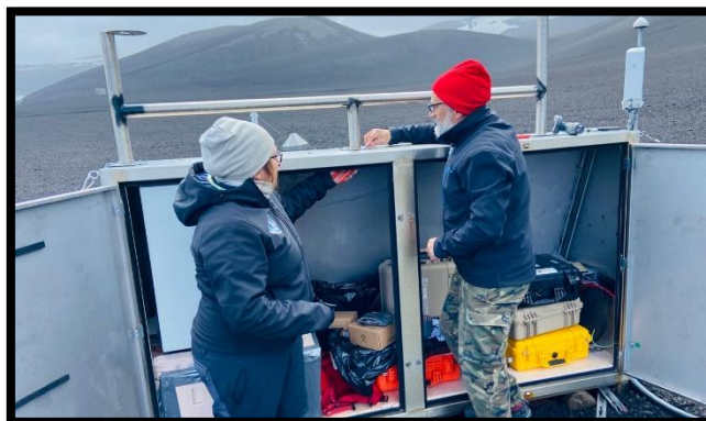
Instalación de nueva antena de comunicaciones LigoBDL en la estación CHI
