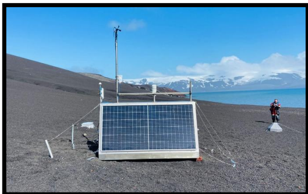
Instalación de infraestructura y puesta en funcionamiento de la estación meteorológica en la estación CHI
