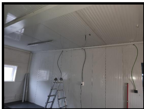
Replanteo de las luminarias
