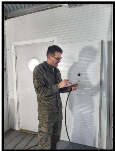
Jorge realizando tareas en la red eléctrica
