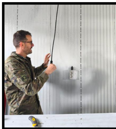
Jorge instalando la red eléctrica
