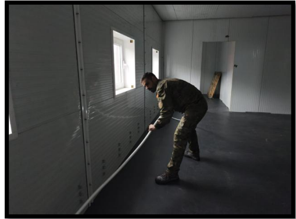
Carlos instalando la red de agua
