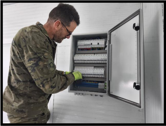
Jorge instalando el cuadro general de la red eléctrica
