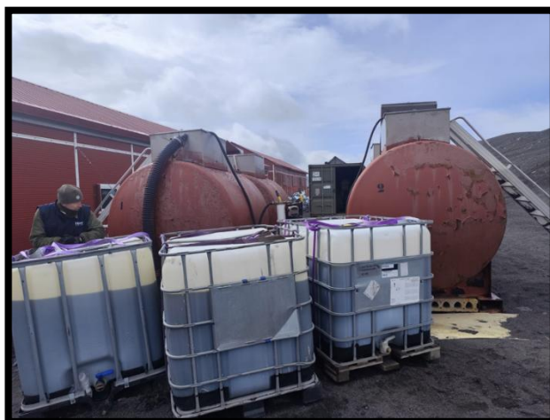
Rodrigo realizando el trasvase de combustible
