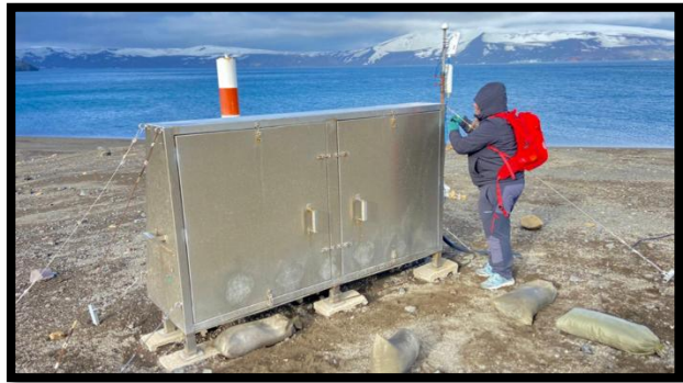
Vanessa instalando la antena WIFI en la estación de Fumarolas
