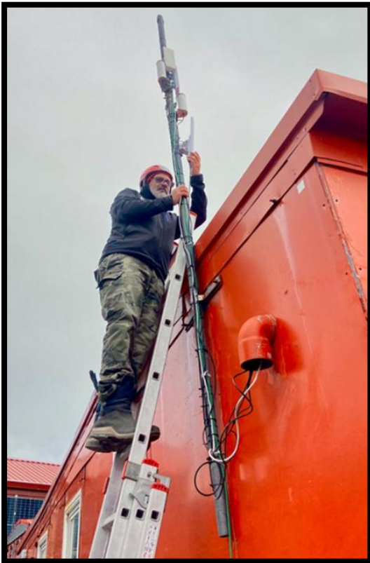
Rafa instalando la antena WiFi en el módulo científico
