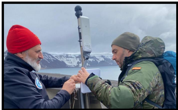
Rafa e Ignacio instalando la antena WIFI en la estación de BASE
