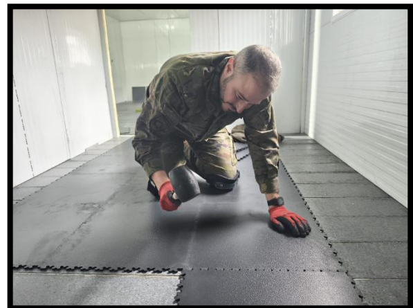
Rubén macías González colocando las losetas del suelo
