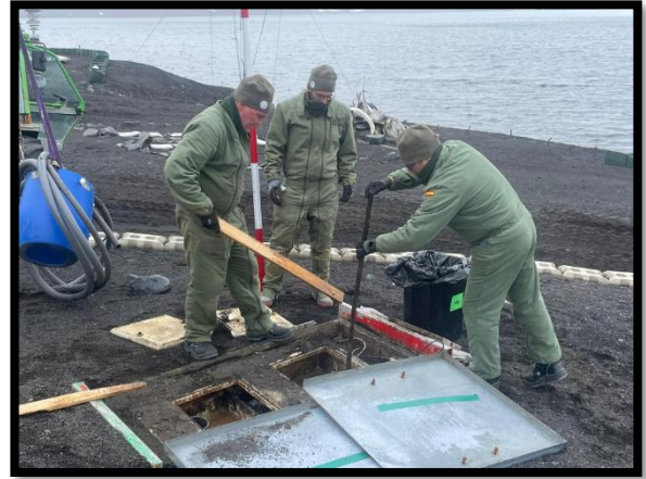
Vaciado controlado de la fosa séptica
