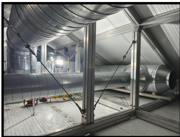
Fan-coils conectados al sistema de climatización
