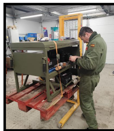
Rodrigo reparando un grupo electrógeno SPA de 6,5 kVA
