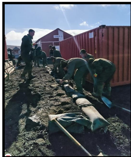
Trabajos de adecuación y limpieza de los exteriores de la BAE GdC
