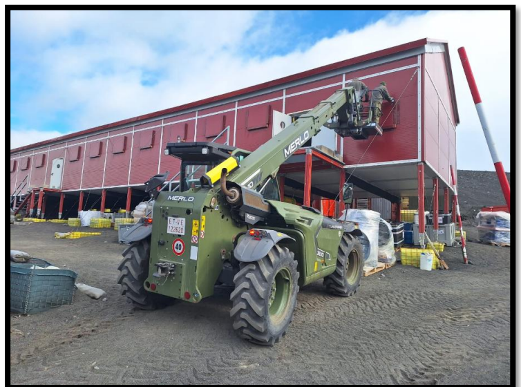
Personal del MING retirando las contraventanas del nuevo módulo científico
