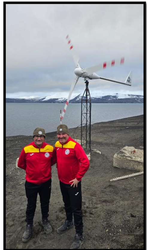
Antonio y Fidel tras terminar el montaje del nuevo aerogenerador
