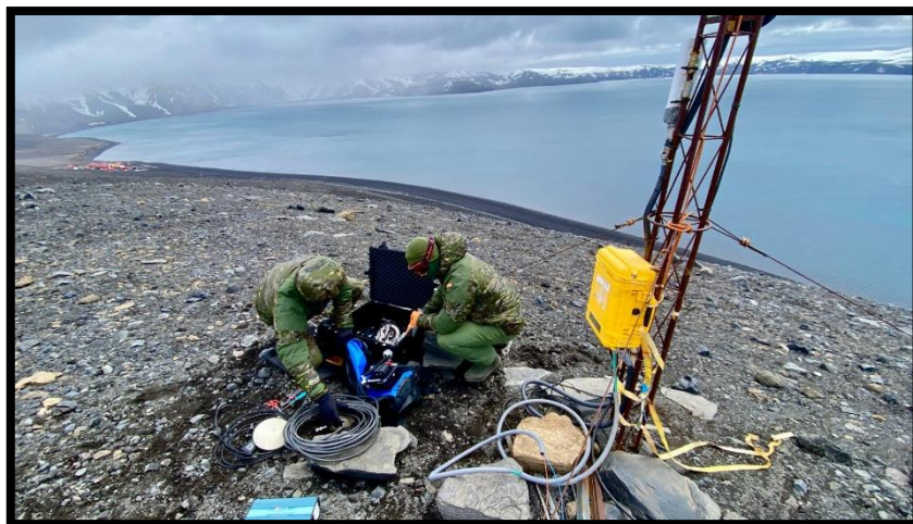
Instalación repetidor VHF, vértice Baliza
