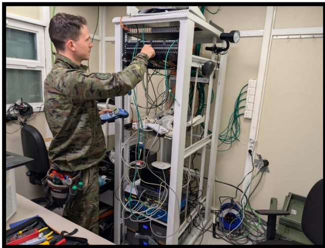
El Capitan Vázquez instalando el Centro de Comunicaciones
