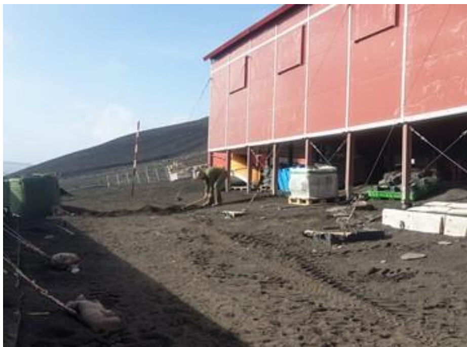
Mejora en el enterramiento de cableado
