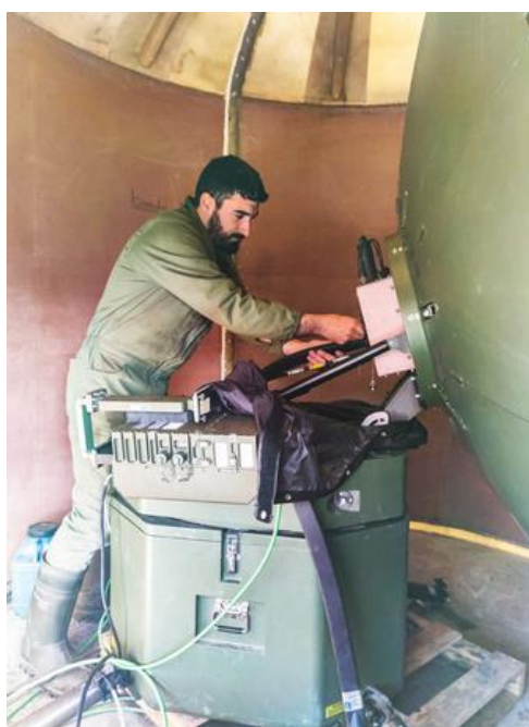
Desmontaje del satélite IP que da enlace con España
