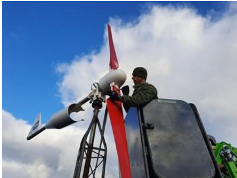
David del área de instalaciones bajando el aerogenerador
