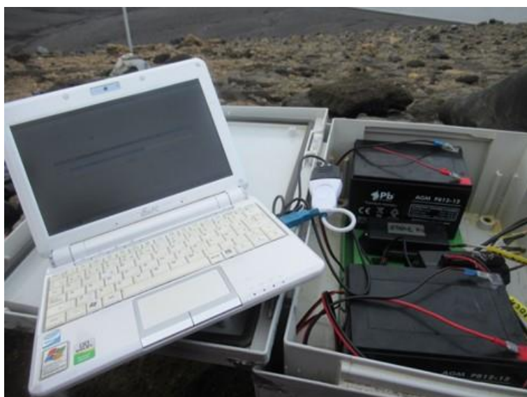
Descarga de datos de la estación en Cerro Caliente
