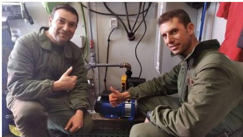
Alberto y David del área de instalaciones tras el cambio de la bomba de agua
