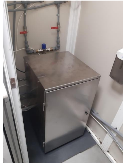
Nueva planta potabilizadora en zona de vida
