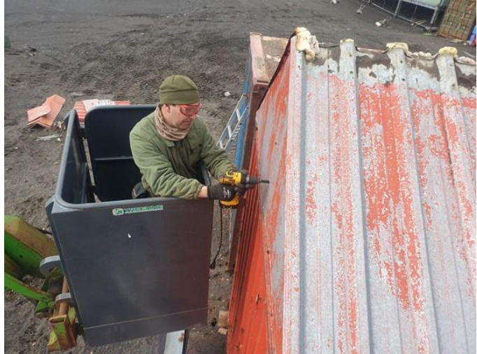
Revestimiento de contenedores
