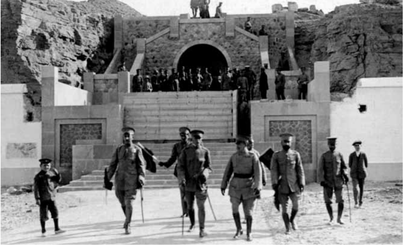
Visita de inspección a las obras del Panteón de Héroes, hacia 1913
