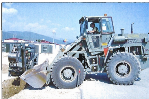
La Unidad de Ingenieros ha realizado trabajos de explanación y pavimentación
