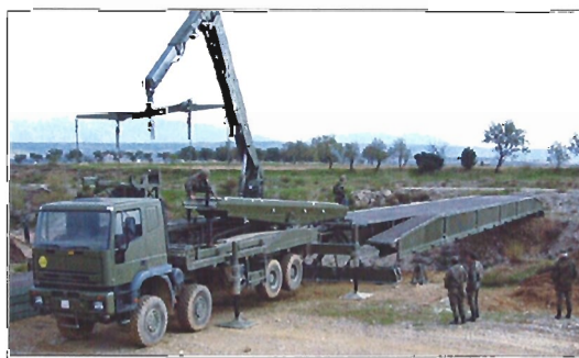
En el ejercicio se practicó el montaje y paso de los puentes de Ingenieros
