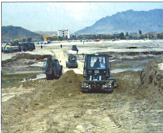
Los Ingenieros prosiguen con la reconstrucción de carreteras y edificios en Kabul
